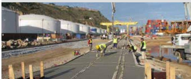
EXTENSION TERMINAL FERROVIAIRE QUAI SUD – PHASE II B
