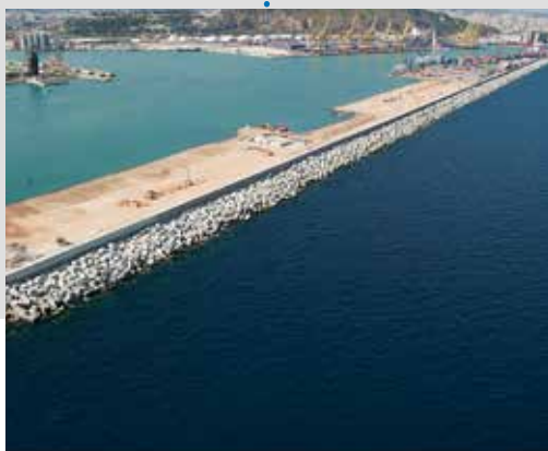
AMÉLIORATION DE LA DIGUE EST – PHASE 4
