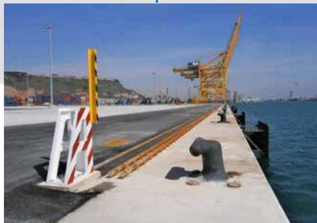
EXTENSION ZONE DE MANŒUVRE, TERMINAL QUAI SUD
