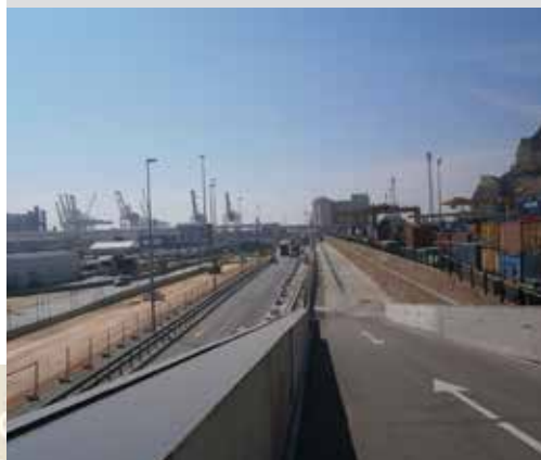
AMÉNAGEMENT VOIRIE ZONE III (AMÉNAGEMENT DU QUAI COSTA)
