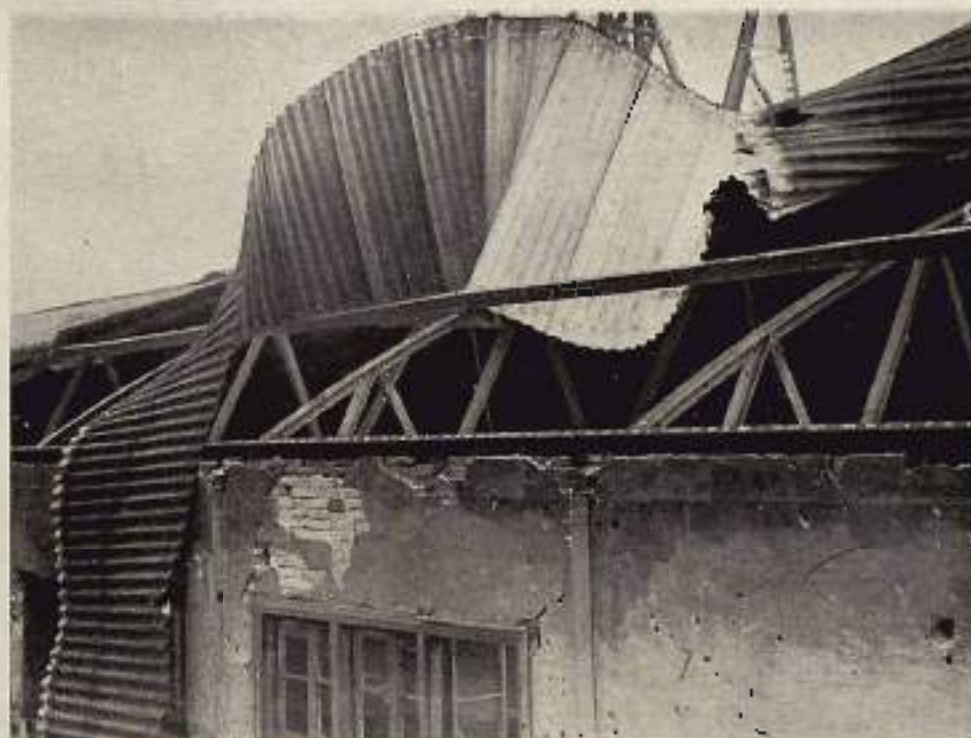
MUELLE DE BARCELONA VISTO GENERAL Y DETALLE DEL TINGLADO N.º 4
