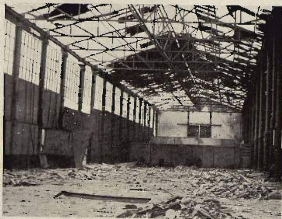
MUELLE DE BALCARES
