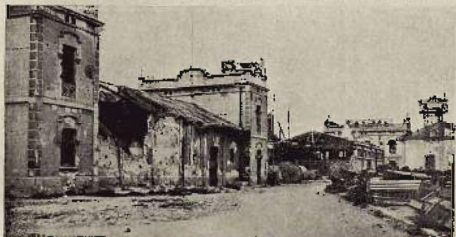
MUELLE DE LEVANTE, FACHADA ESTE DEL CUERPO DE "ALMACÉN DE BOMBAS DEL ESTADO"
