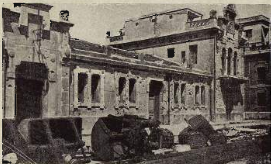
MUELLE ORIENTAL, CAÍDA DEL MISMO EDIFICIO. "ALMACÉN GENERAL DE LAS OBRAS"
