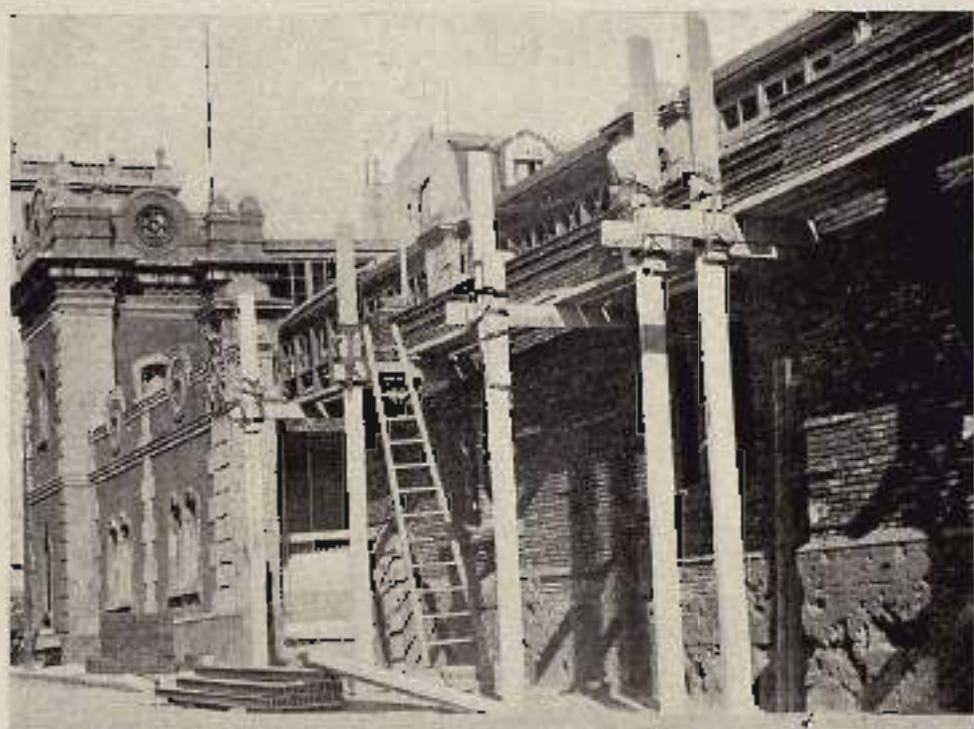
MUELLE DE LA BARCELONETA CONSTRUCCIÓN DEL TERCERO S.º 2.º Y REPARACIÓN
