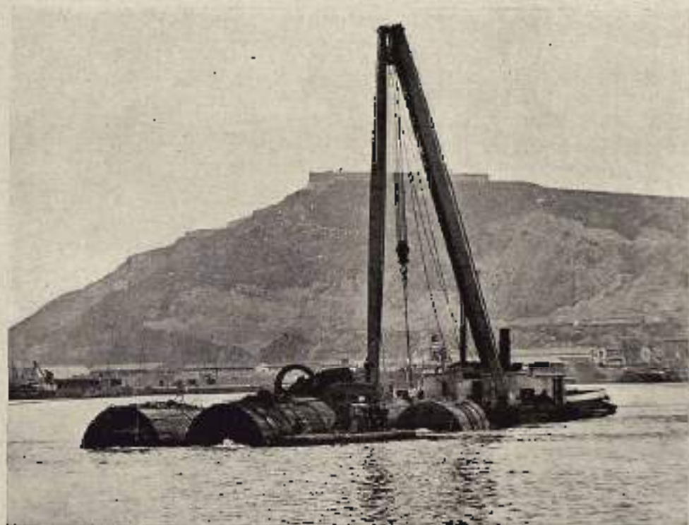
LA CABLEA "ESPERANZA" DE 50 TONELADAS EN LOS TRABAJOS DE SACAMENTO DE LA DRAGA JOSABIG DE ESTA JUNTA DE OBRAS
