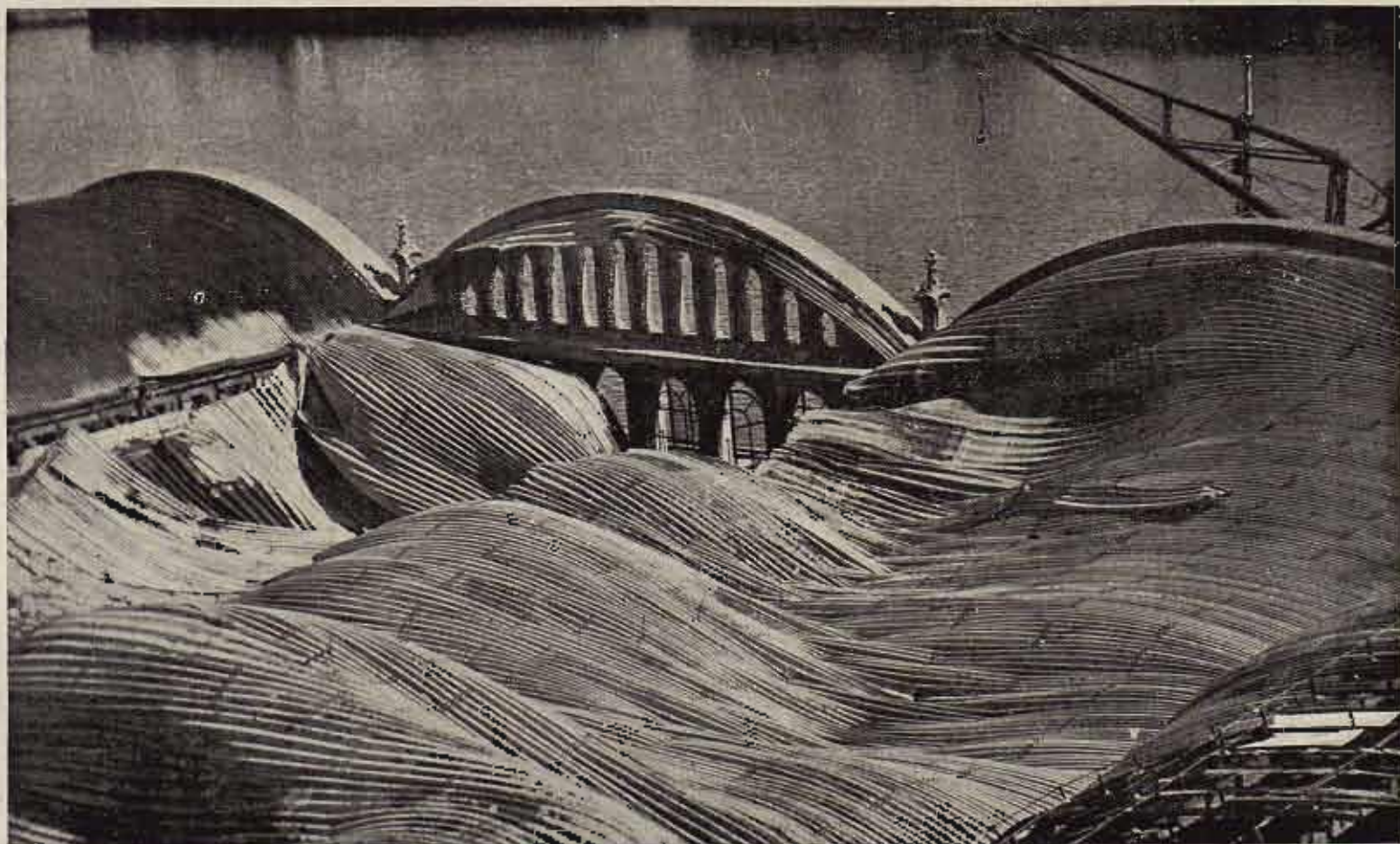
MUELLE DE BOSCH Y ALSINA ASPECTO EXTERIOR DE LA CUBIERTA DEL Muelle N.º 2
