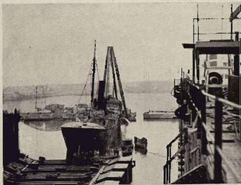
EL "ESPERANZA" CABLE 30 TONELADAS AYUDANDO DE LA CABLE EN ESCORA DE ENCLAVAR EN TORQUE
