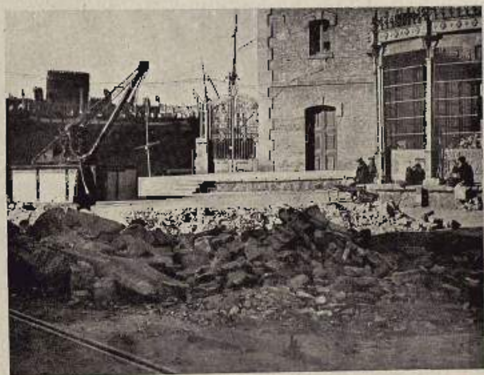
MUELLES DE BARRIÉS Y BARRIETA DOS ASPECTOS DE LAS DESTRUCCIONES OCASIONADAS EN ESTOS MUELLES
