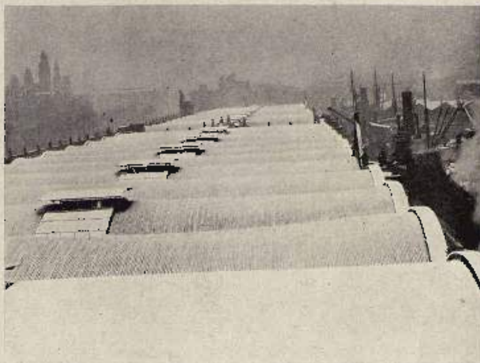
UNA BUENA FOTOGRAFÍA DE LAS CUBIERTAS DE LOS PESQUEROS NÚMEROS 1 Y 2 DEL PUERTO DE MÉRIDA, DESPUÉS DE UNA NEVADA
