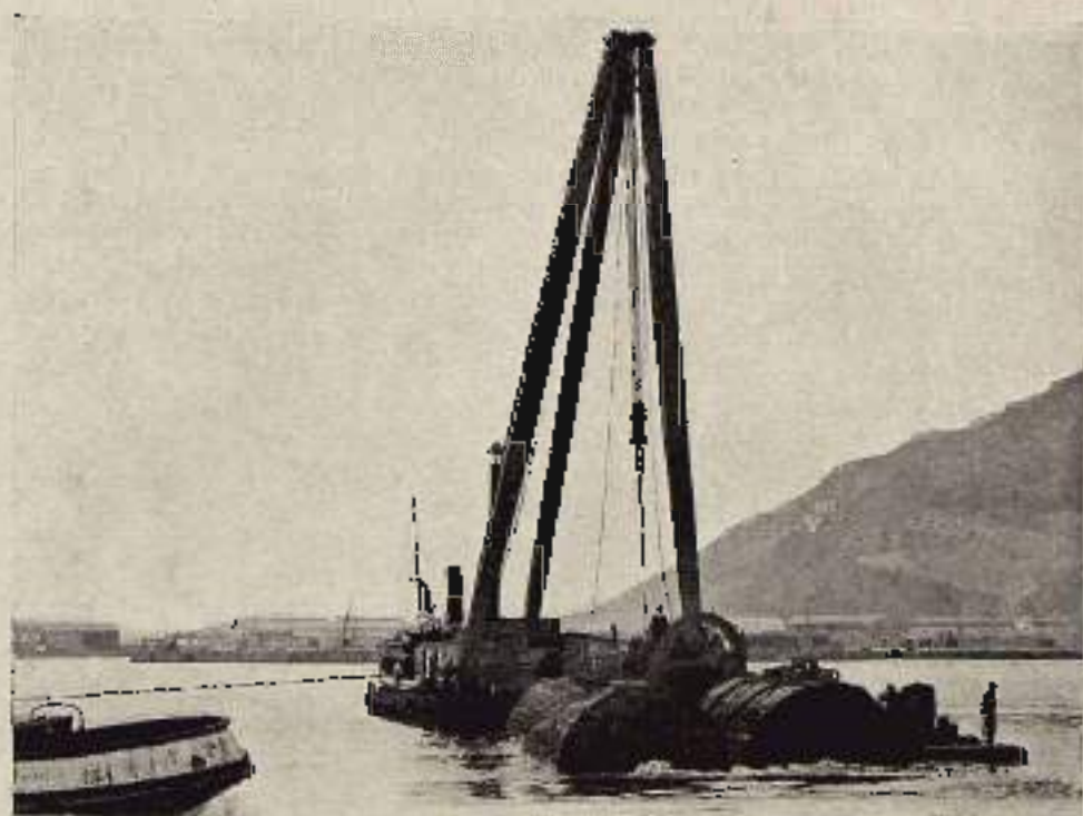
LA DRAGA TRABAJA EN ESTA JUNTA DE OBRAS SOSTENIDA POR LA CABLEA DE 50 TONELADAS, JUNTO CON LOS FLOPANTES, DESPLAZÁNDOSE HACIA LA DERECHA DEL DIQUE PLAZATE
