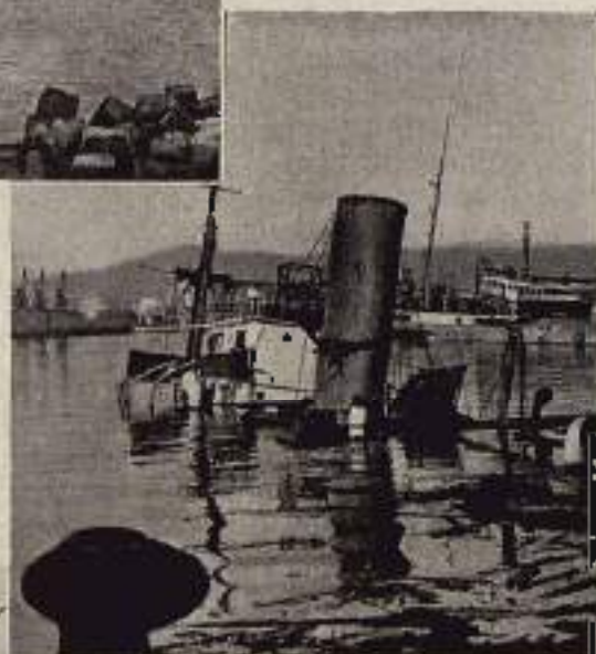
VISTA DEL PUERTO DE SAN MIGUEL ARRIYA EN PRIMER PLANO Y EL MUELLE DE CARGA "MIGUEL"
