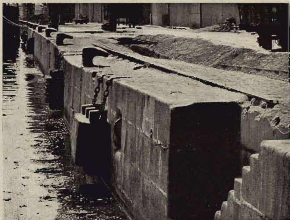
MUELLE DE BAZOFLONA (PARTE NOROCCIDENTAL) DETALLE DE UN TRAMO DEL MURO DE MUELLE.
