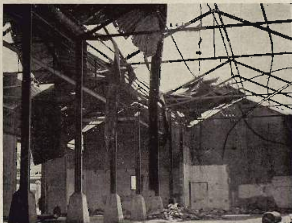
MUELLE DE ESPAÑA VISTA INTERIOR DEL TALLER N.º 7
