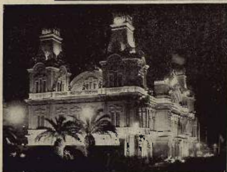
VISTA DE CON- JUNTO DEL MIS- MO EDIFICIO
