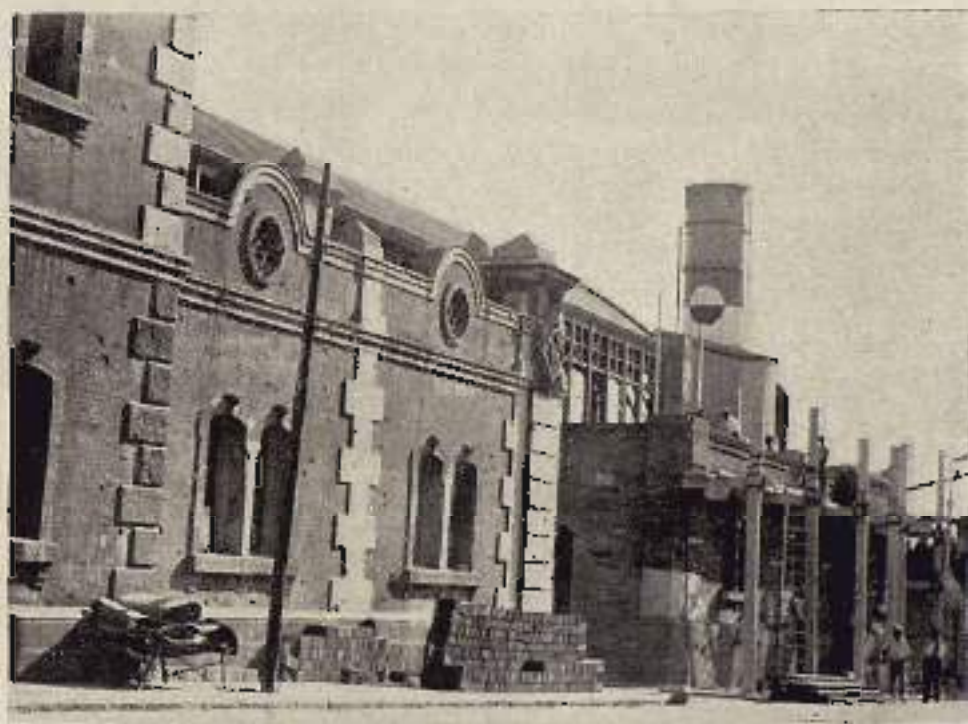
MUELLE DE LA BARCELONETA CONSTRUCCIÓN DEL TERCERO S.º 2.º DEL TIPOLO S.º 2
