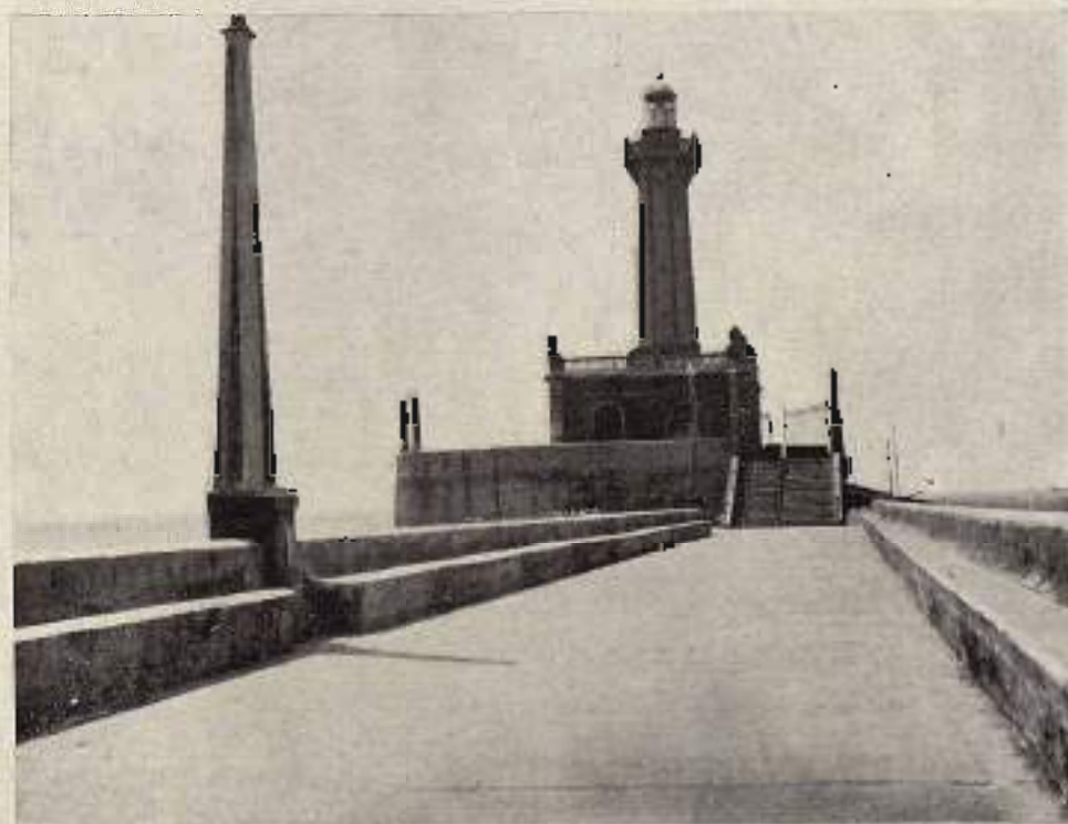
VISTA DEL PABLO DEL BOMBEO ASÍ COMO Y TERMINACIÓN LAS OBRAS DE REPARACIÓN
