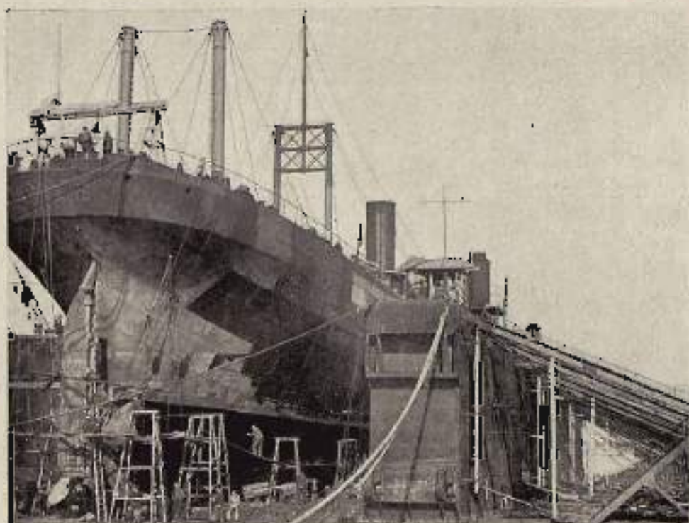
EL "CASTRO DE S. PEDRO" EN DIQUE, BASTA DE 10.000 TONELADAS DE CABLE QUE LE SOSTIENEN.
