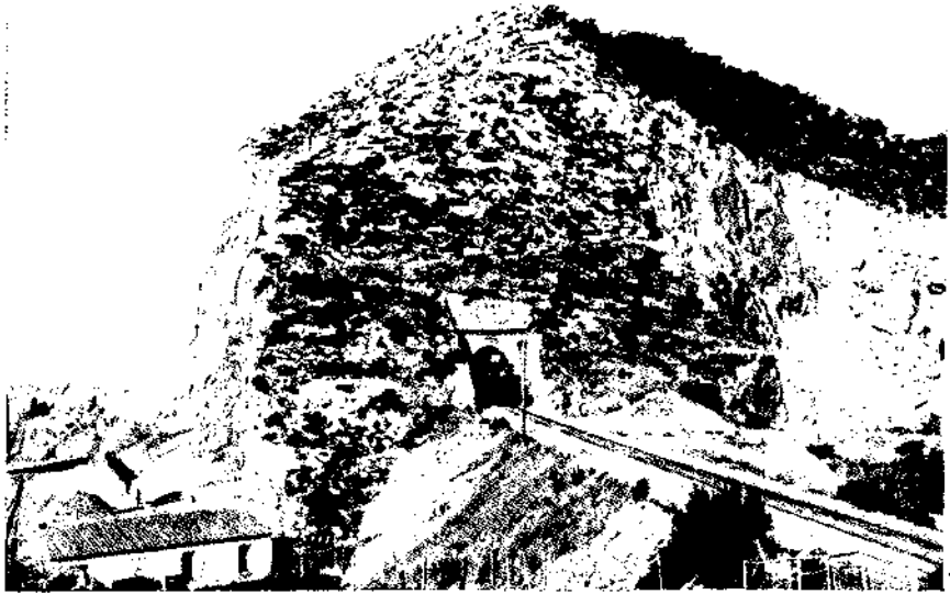
CERRO DE «LA FALCONERA» Y TÚNEL DEL FERROCARRIL.—CANTERA DEL LADO SUR O DEL MAR
