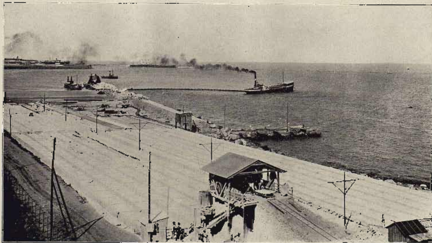
VISTA GENERAL DEL TALLER DE BLOQUES Y DE LOS ELEMENTOS PARA LA CONSTRUCCION DE LAS OBRAS
