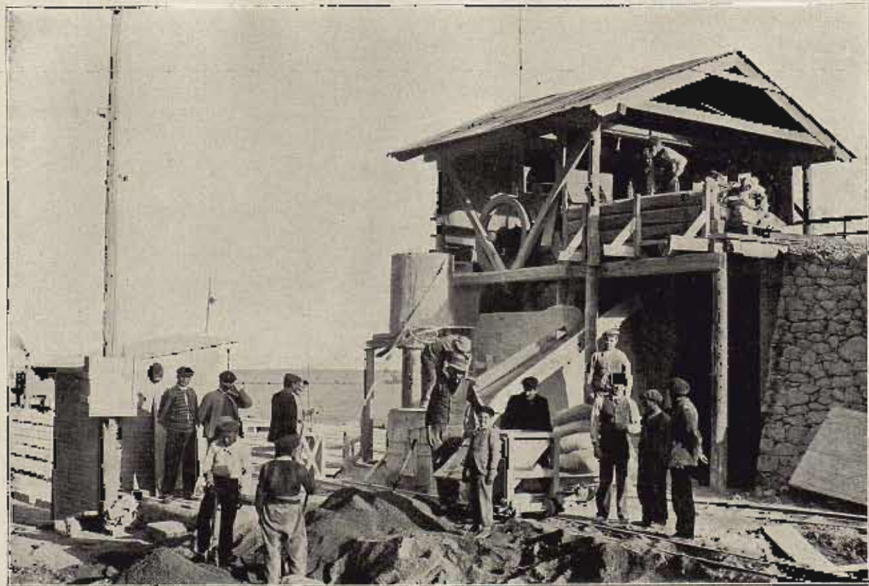
TALLER DE BLENDES — INSTALACION PARA FABRICAR EL HORMIGÓN.
