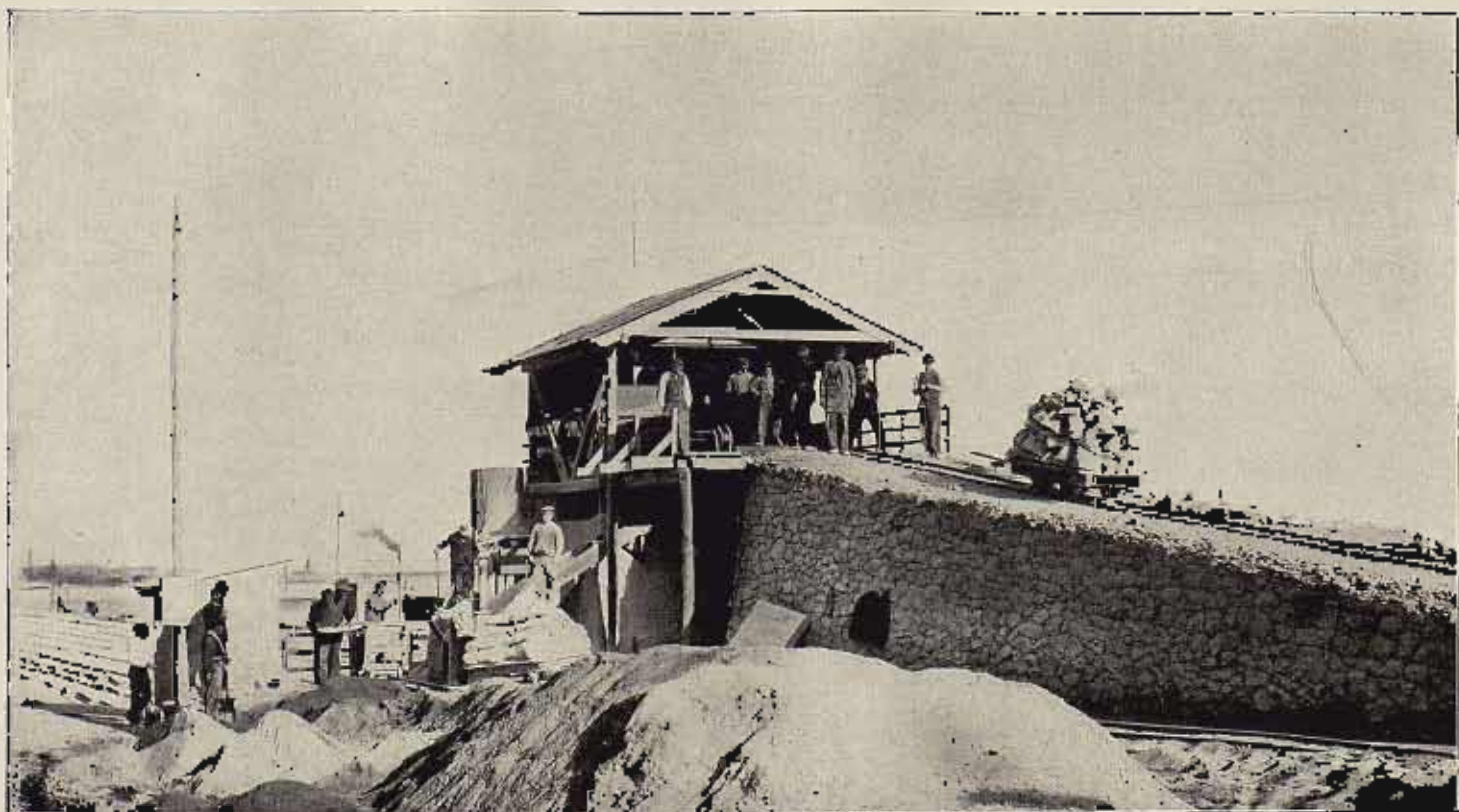
TALLEY DE BLOQUES — INSTALACIÓN PARA FABRICAR EL HORMIGÓN: RAMPA DE ACCESO DE LA PIEDRA A LA MACHACADORA, DEPOSITOS DE ARENA, CALY AGUA
