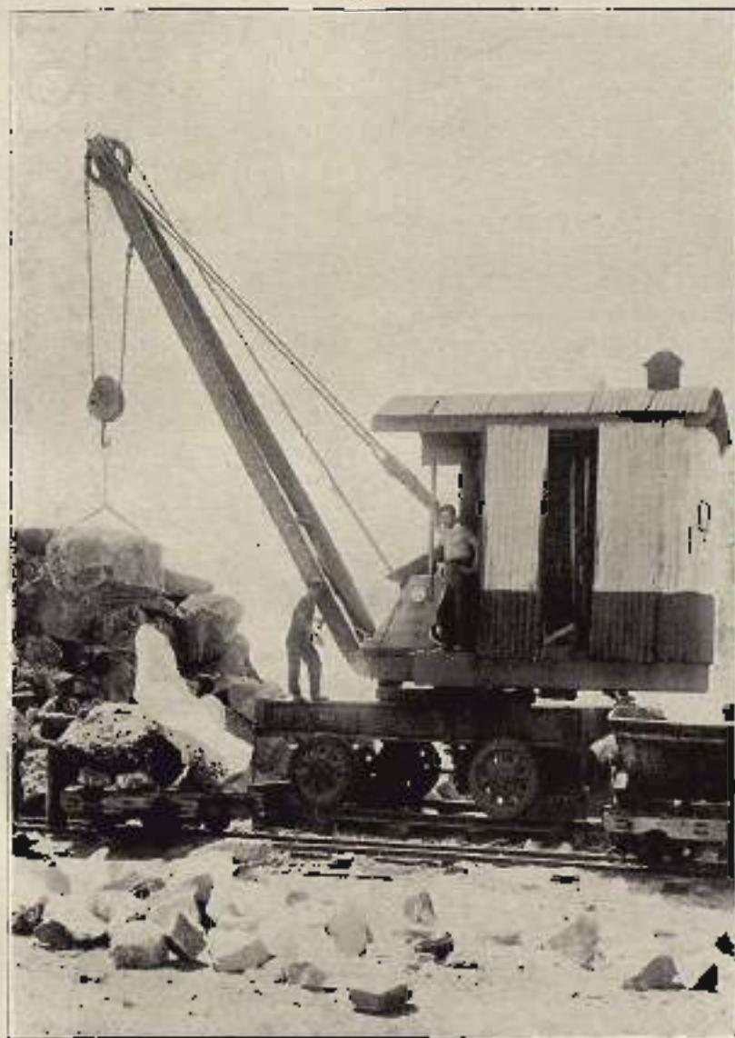
GRUA MÓVIL DE VAPOR DE FIERRO CONEJADAS PARA LA EXTRACCIÓN DE LA DEGRADERA DEL ESPALDON DEL ANTERIOR INGENIO DE BOMBIER.
