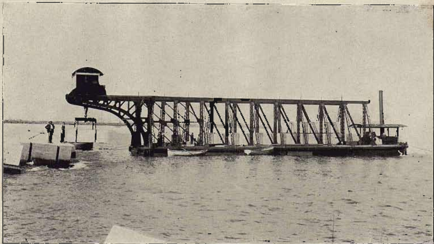
CÁBRIA FLOJANTE «FRANCIS» PARA LA COLOCACIÓN DE LOS BLOQUES
