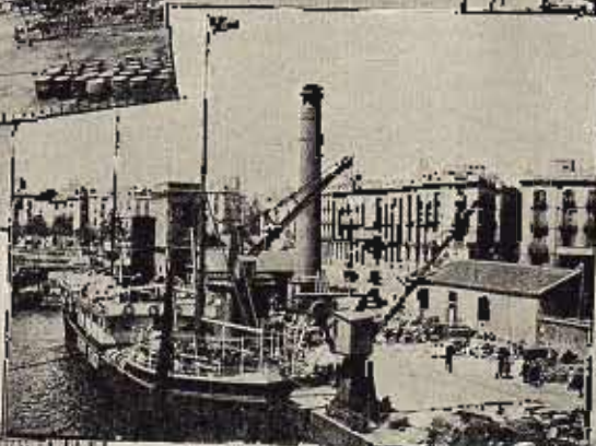
MUELLE DEL DEPÓSITO
