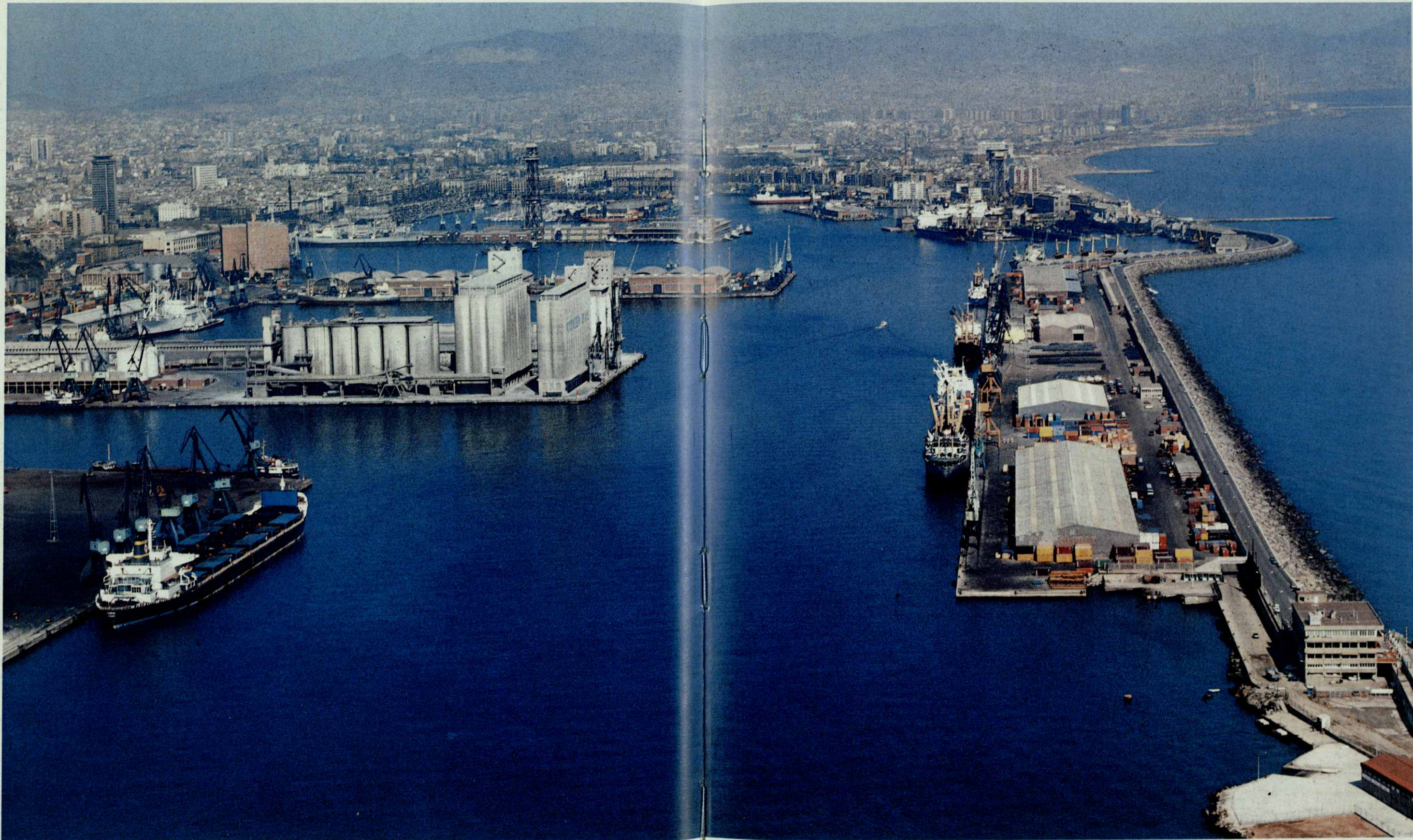
Vista general del canal de acceso a dársenas.
