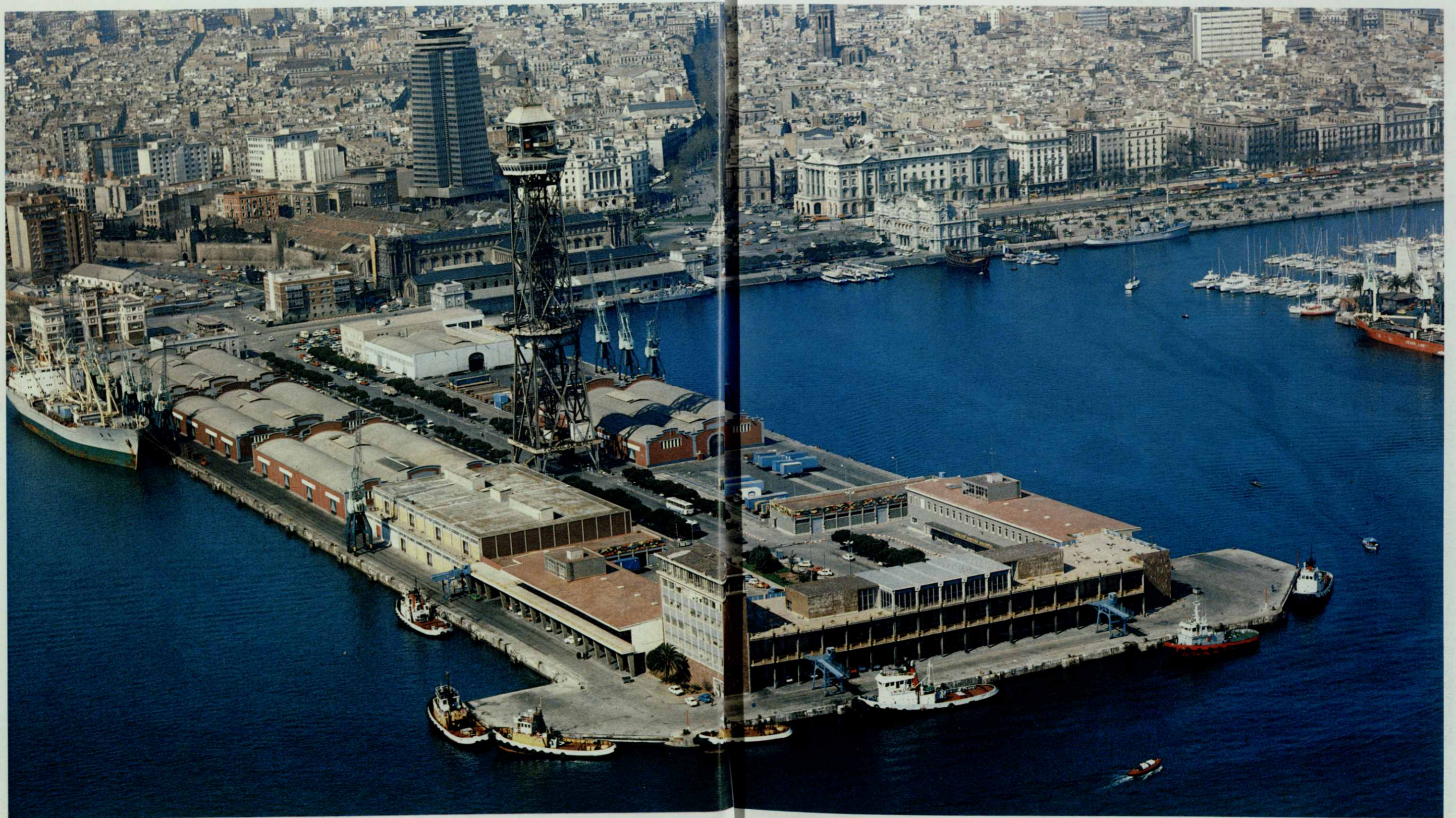
Modernización del muelle de España. En primer término puerto pesquero.
