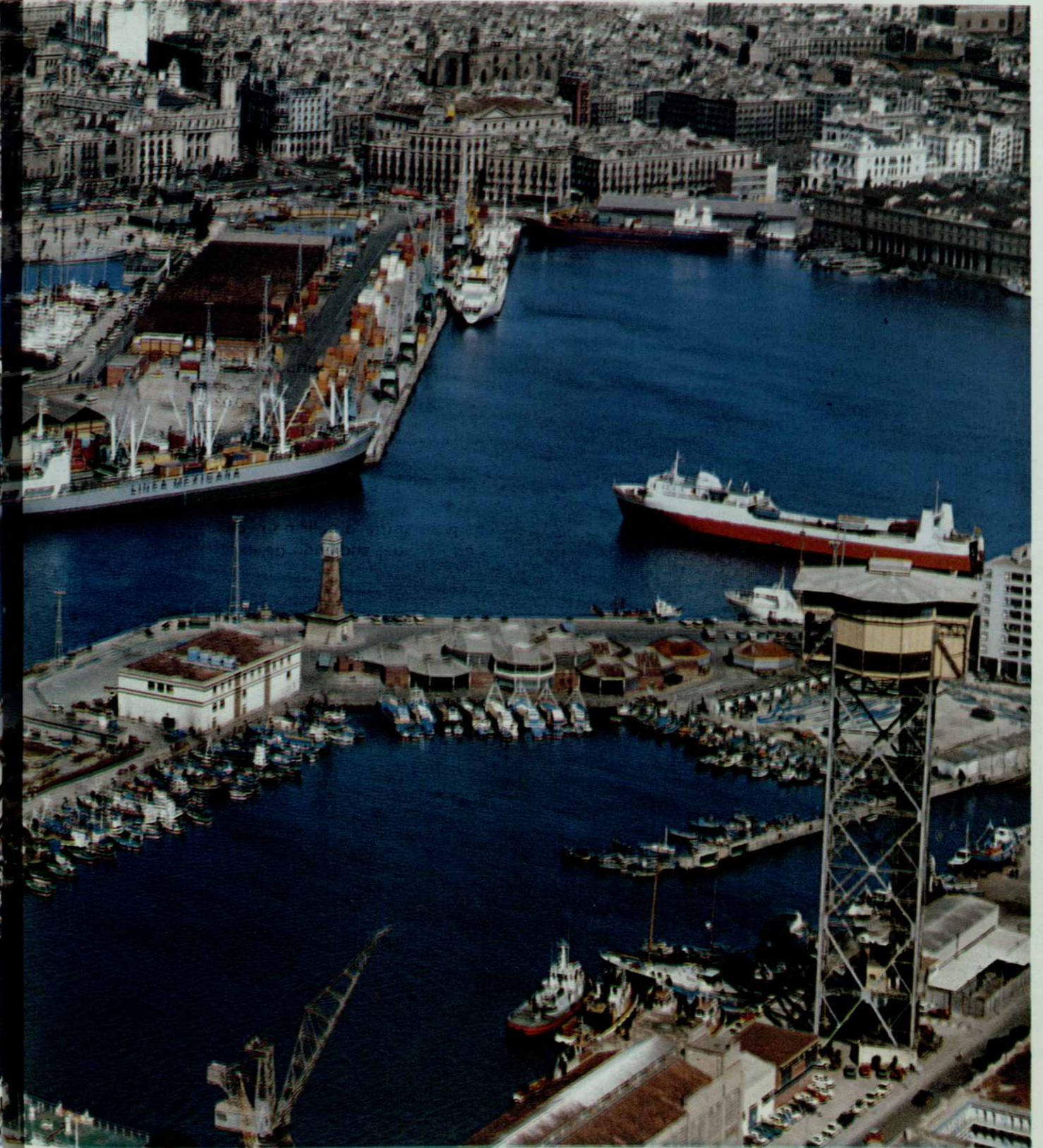
Modernización del Muelle de España. En primer término Puerto Pesquero.
