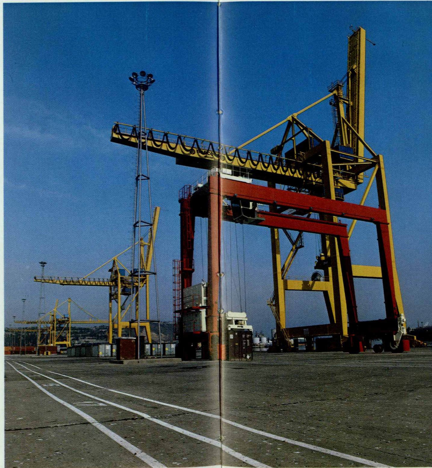
Muelle Príncipe de España. Utillaje para manipulación de contenedores.
