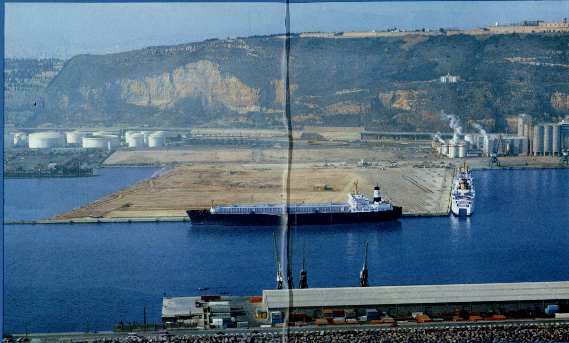
Obras de Pavimentación del Muelle Sur n.º 1.
