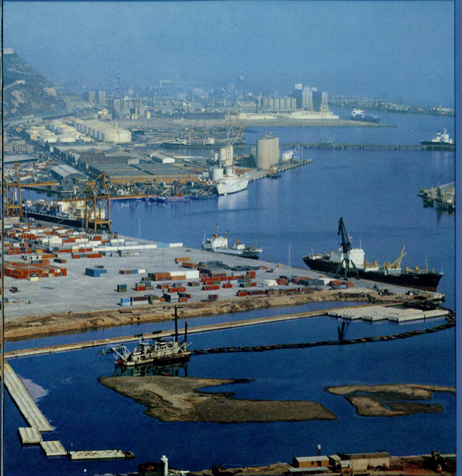
Obra de la Dársena Sur del Muelle Príncipe de España, y al fondo la Terminal de Contenedores.
