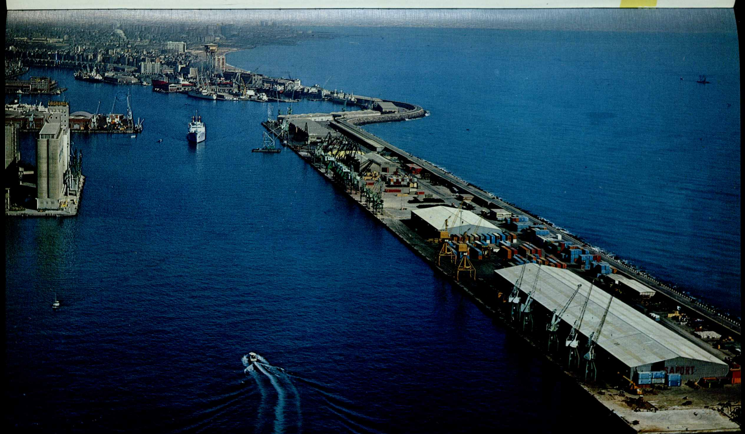
Muelle Adosado. En primer término a la derecha, obras para atraque de buques ro-ro
