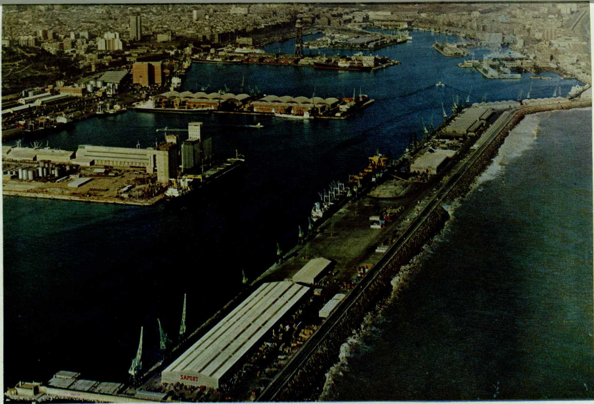
Muelle de Adosado en primer término y vista general de la Zona Norte del Puerto
