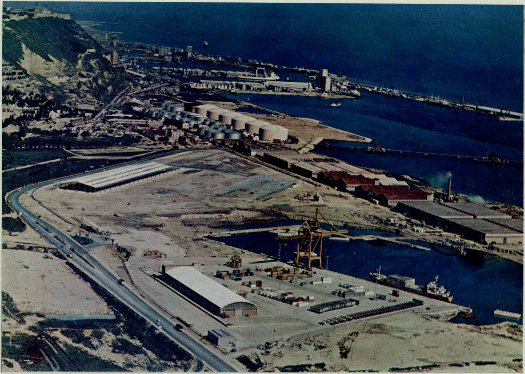
Vista general del Terminal para Contenedores y Transportes Combinados, en construcción.
