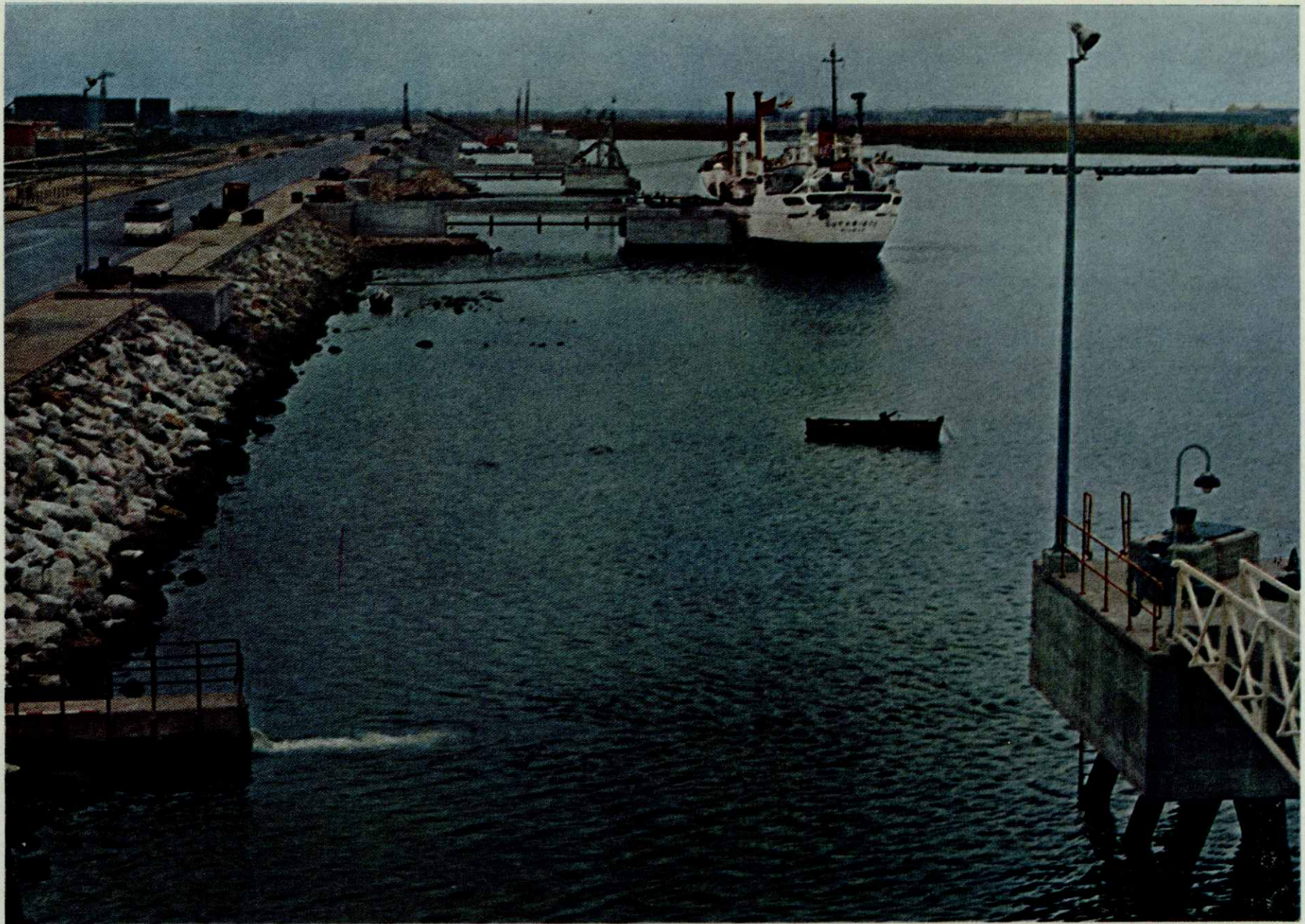
Atraques en construcción para graneles líquidos
