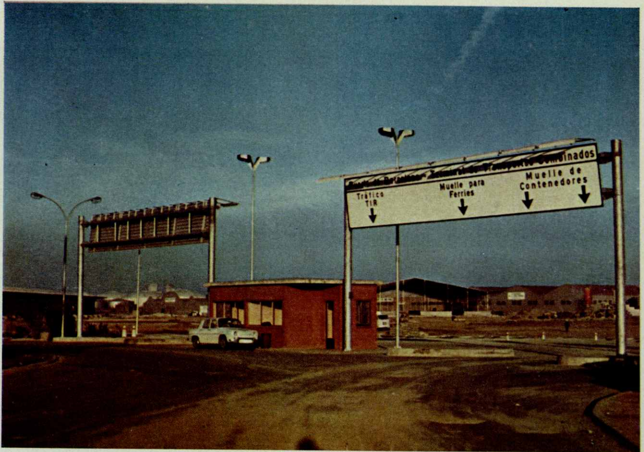
Accesos a la Nueva Terminal de Transportes Combinado.
