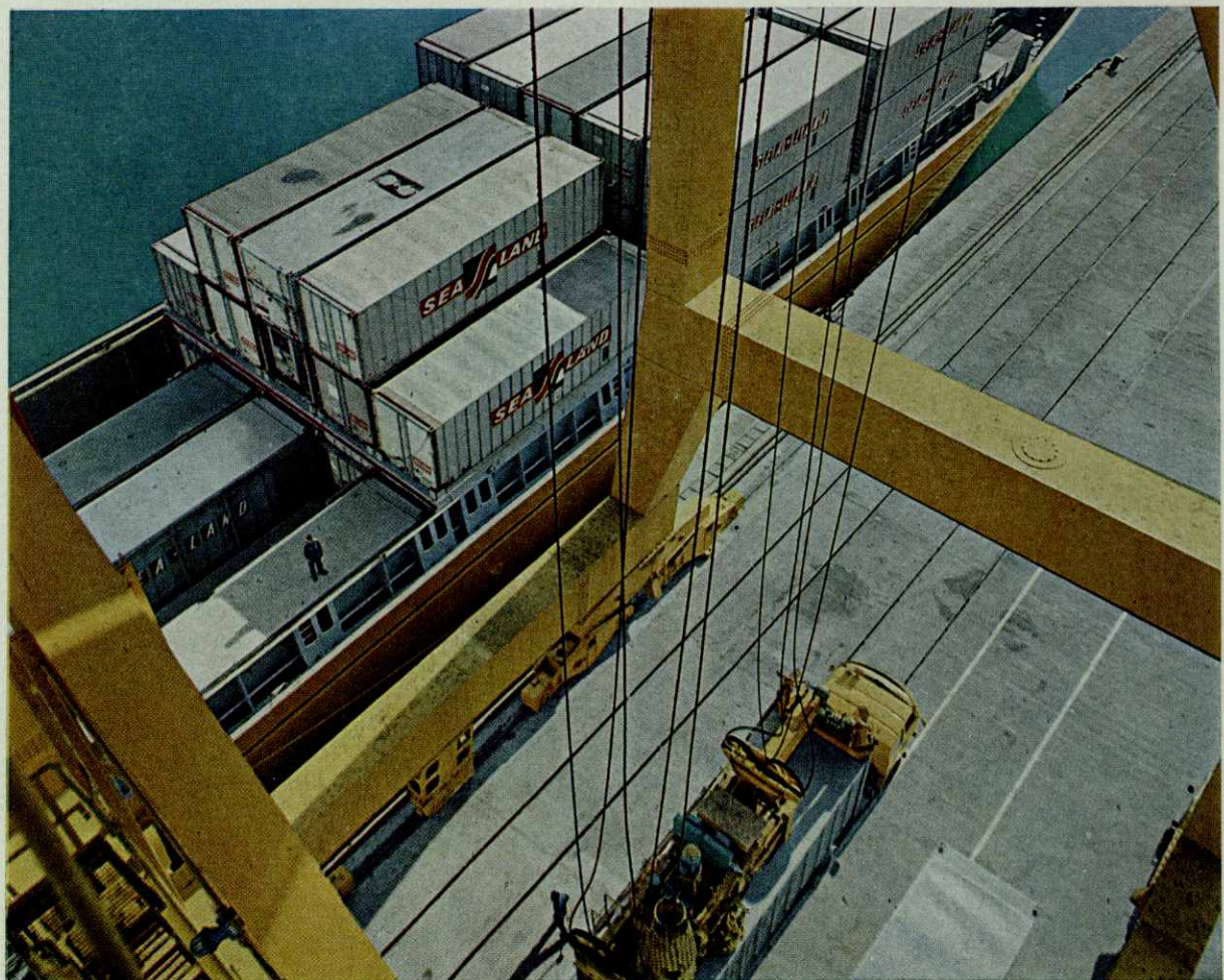
Puente - Grúa de 50 Tons. para Contenedores en el Muelle Príncipe de España.
