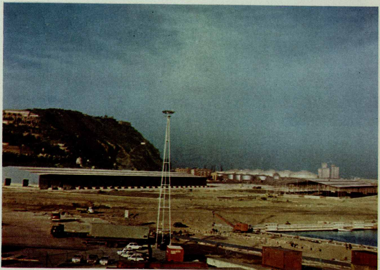
Terminal de Transportes Combinados en construcción.
