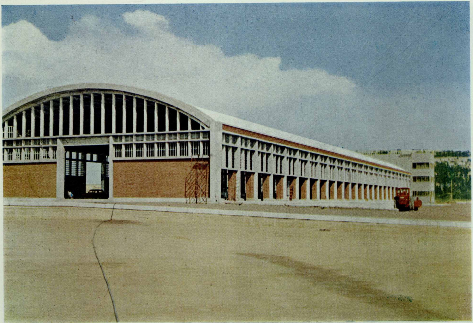
Nuevo tinglado en el Muelle de Containers
