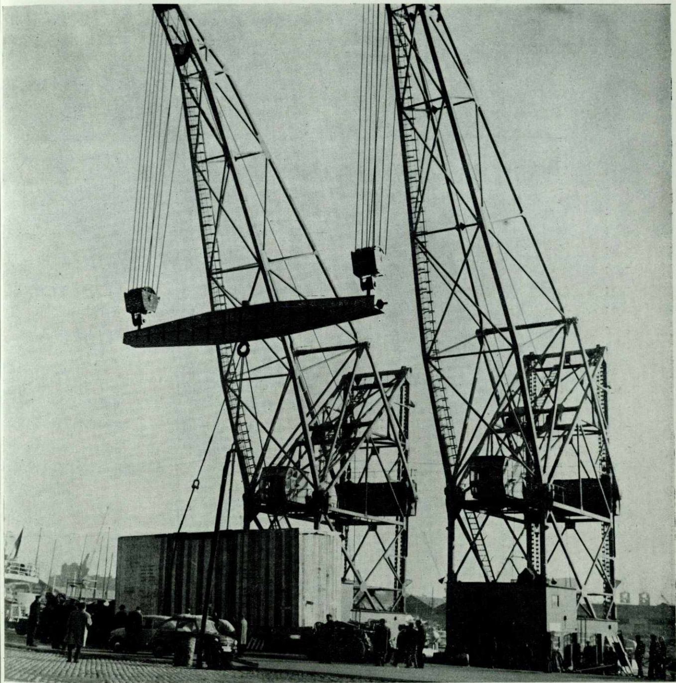
Balancín para trabajo en paralelo de dos grúas flotantes. hasta 160 Tons.
