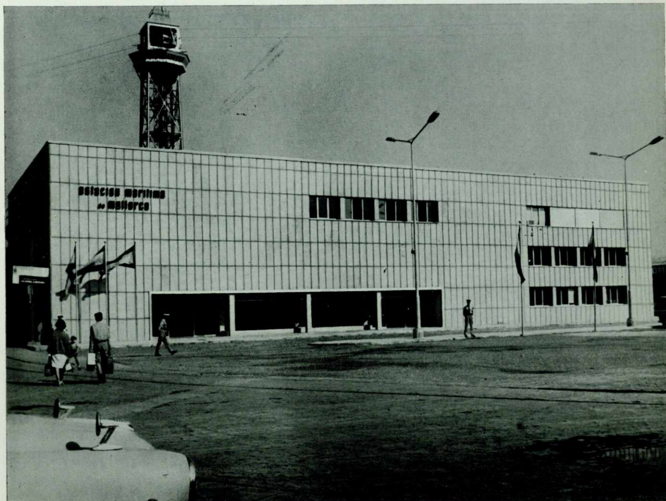
Fachada principal de la nueva Estación Marítima de Mallorca
