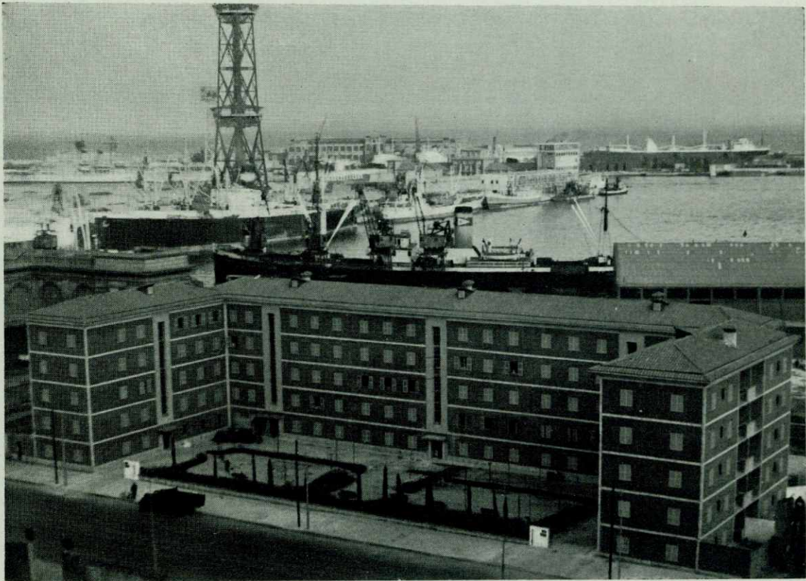
Bloque de cincuenta viviendas para obreros de la Junta de Obras del Puerto
