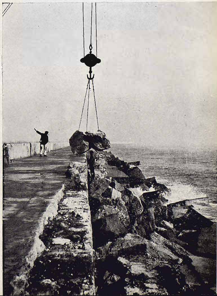
Trabajos de preparación del talud exterior de la defensa
