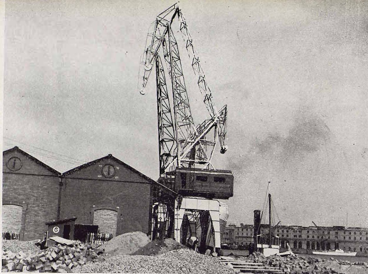
Una parte de las catorce grúas nuevas de 7/6 Tn. en período de construcción y montaje
