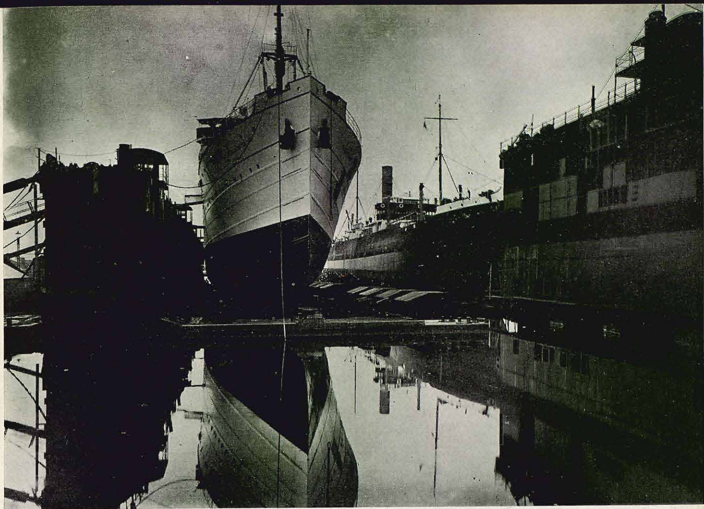
Dique Flotante y deponente con potencia ascensional de 6.000 Tn.
