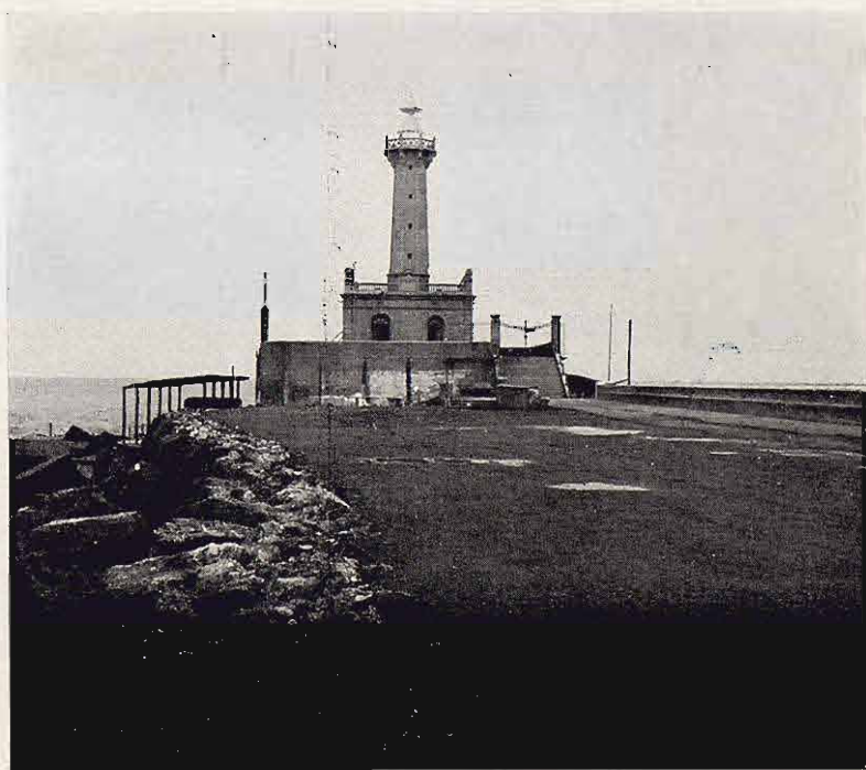
Luz de enfilación de la entrada del Puerto
