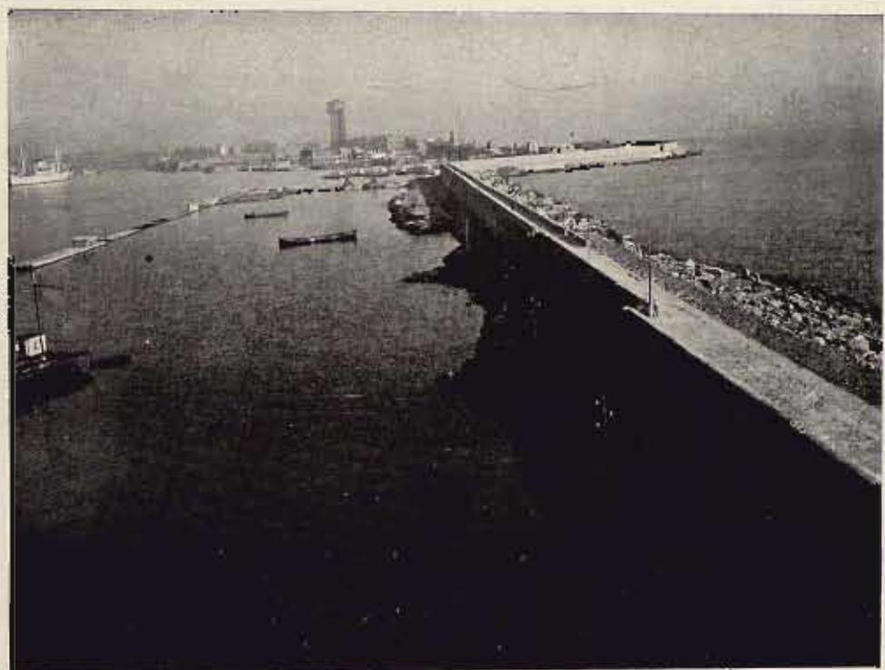
OBRAS DEL PUERTO DEL BUENPOTAS ALBERICO Y LA PROLONGACIÓN DEL DIQUE DEL ESTE
