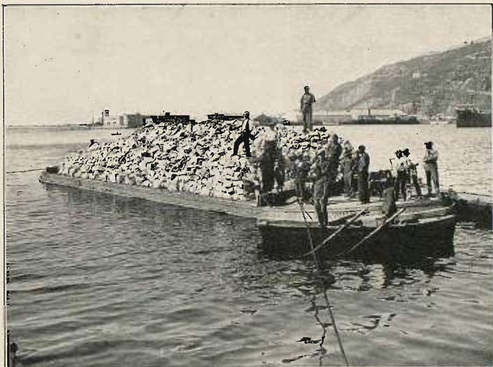
CONSTRUCCIÓN DEL MUELLE ADOSADO AL DIQUE DEL ESTE BARCAZA-VOLQUETE SITUADA PARA VACIAR
