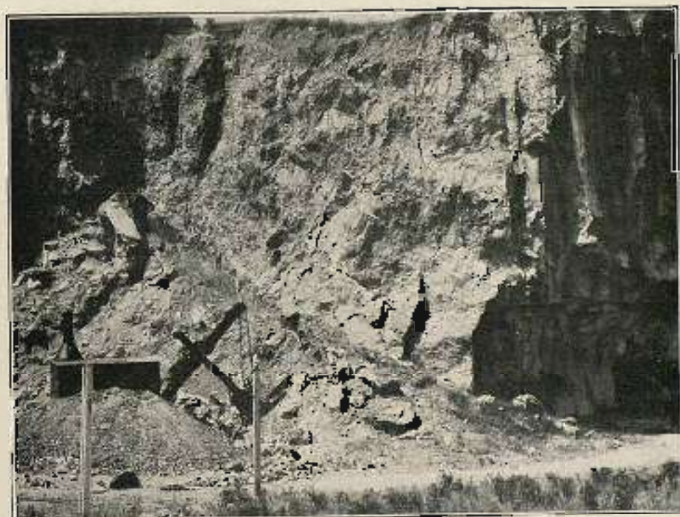
CONSTRUCCIÓN DEL MUJERLE ANEXO AL DIQUE DEL 1876 VISTA DE LAS CÁMARIAS DEL CONTRATISTA
