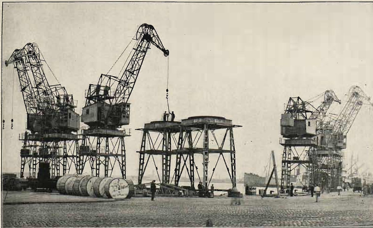
INSTALACIÓN DE 23 GRÚAS ELÉCTRICAS DE 3-6 TONELADAS EN LOS MUELLES DE BARCELONA Y SAN BELTRÁN
