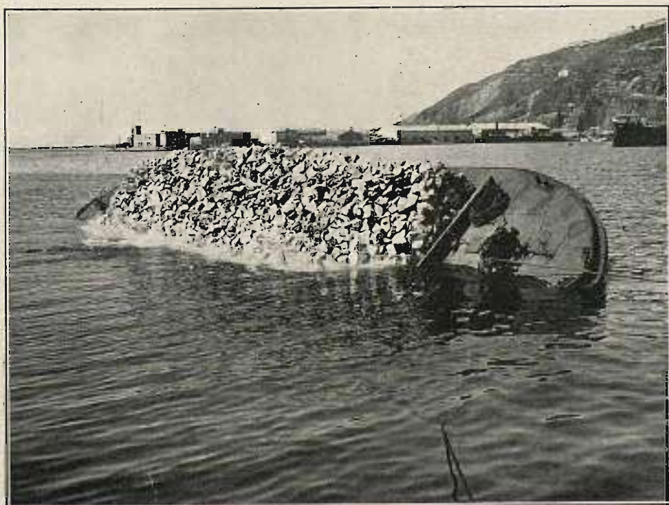
CONSTRUCCIÓN DEL MUELLE ADOSADO AL DIQUE DEL ESTE BARCAZA-VOLQUETE DESCARGANDO
