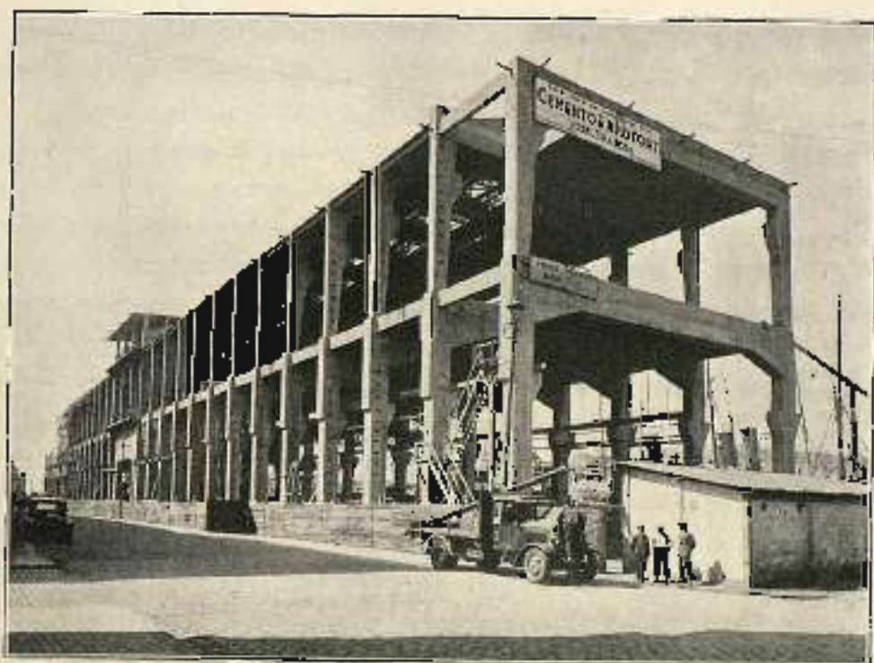
EDIFICIO EN CONSTRUCCIÓN PARA AMPLIAR LOS TALLERES "NUEVO VELAÑO"
