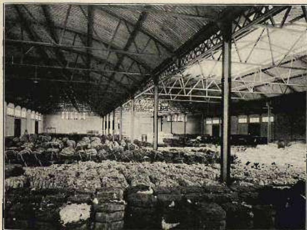
INTERIOR DEL TENDIDO NÚMERO 5 DEL PUERTO DE BARCELONA
