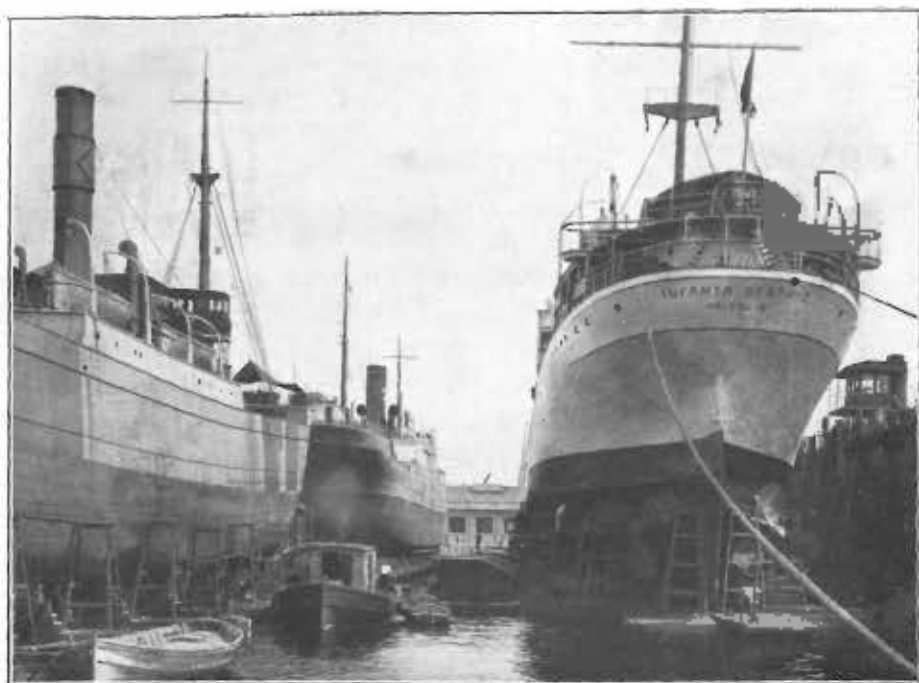
DOS BUQUES GRANDES SOBRE LOS CALENTOS DE PONTÓN. MOTO NAVÉ "INFANTA BEATRIZ" SOBRE TRES SECCIONES DEL DIQUE
