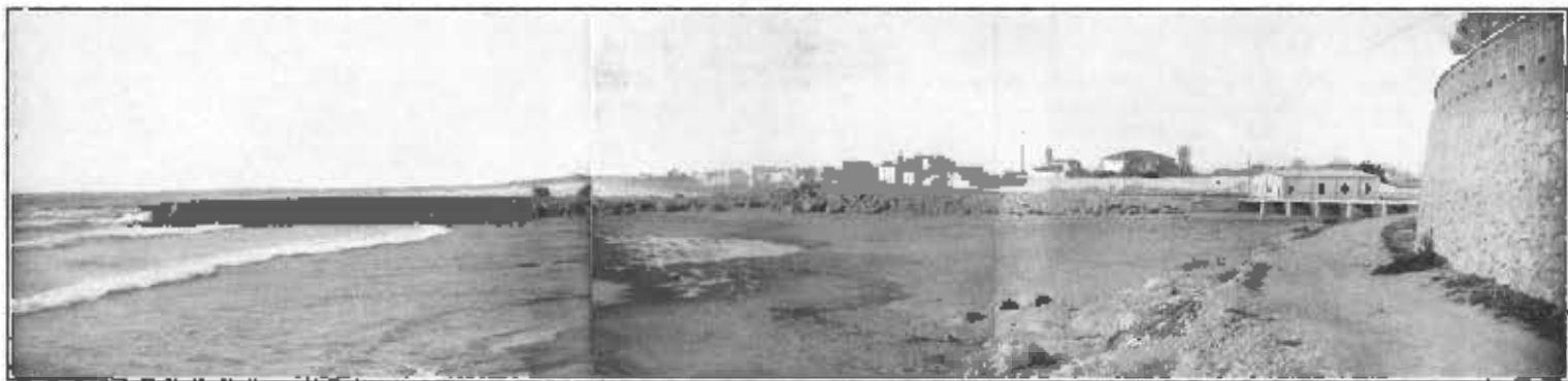
VISTA GENERAL DE LAS OBRAS EN LA PLAYA DE VILLANUEVA Y GELTRÚ
