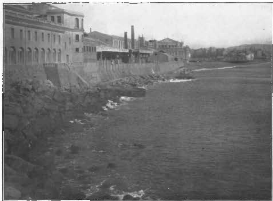
ESTADO DE LA MISMA PLANA, DESPUES DE UNA MAREJADA DEL 2.º CUADRANTE AL FUR
