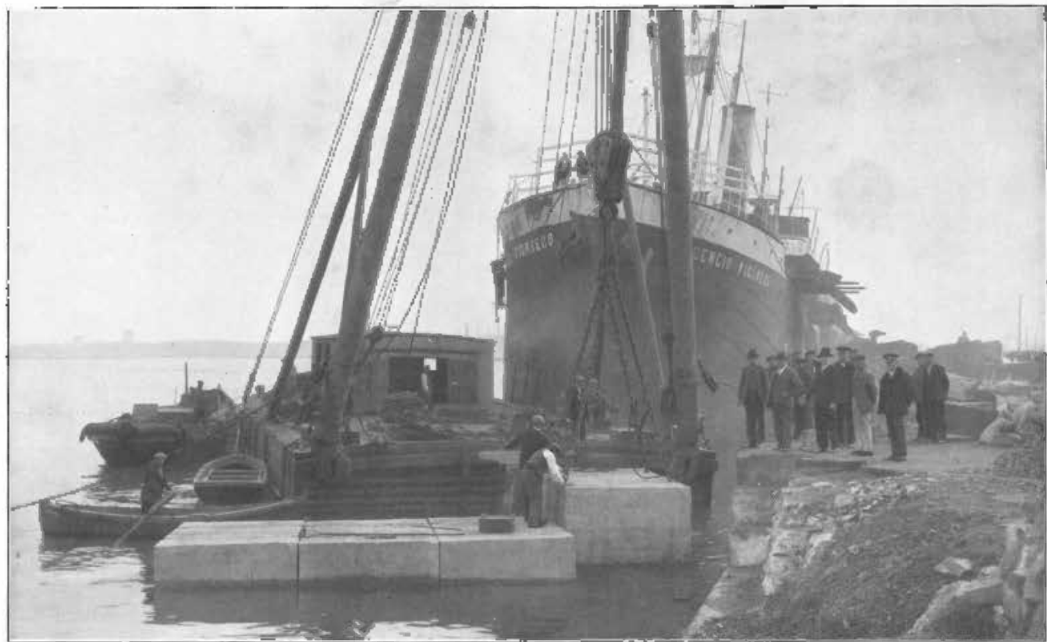
UBICACIÓN DEL ÚLTIMO BLOQUE PARA LA CONSTRUCCIÓN DEL NUEVO MURO DEL MUELLE DE SAN BELTRÁN
