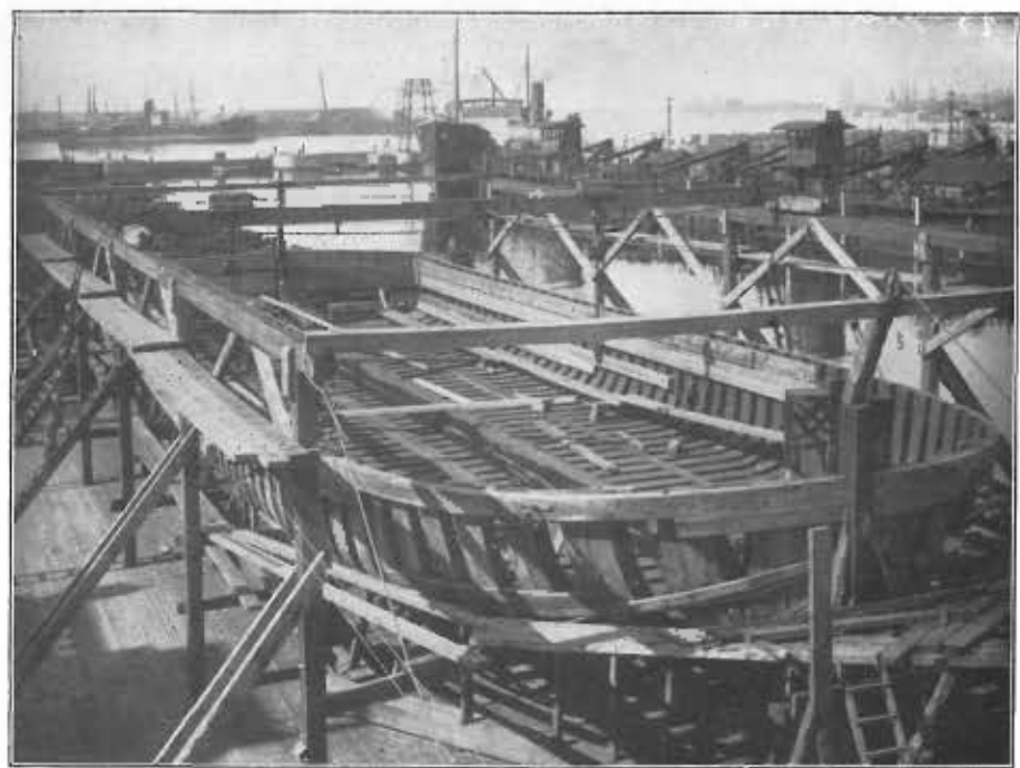
CONSTRUCCIÓN DEL CASCO PARA LA NUEVA CÁRICA "MONSERRAT"
