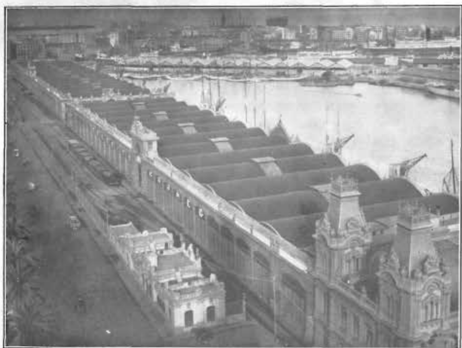
INSTALACIÓN PROVISIONAL DEL DEPÓSITO FRANCO EN LOS DOS TEMPLADOS DEL MUELLE DE BOSCH Y ALSINA (ANTES DE LA GUERRA)
