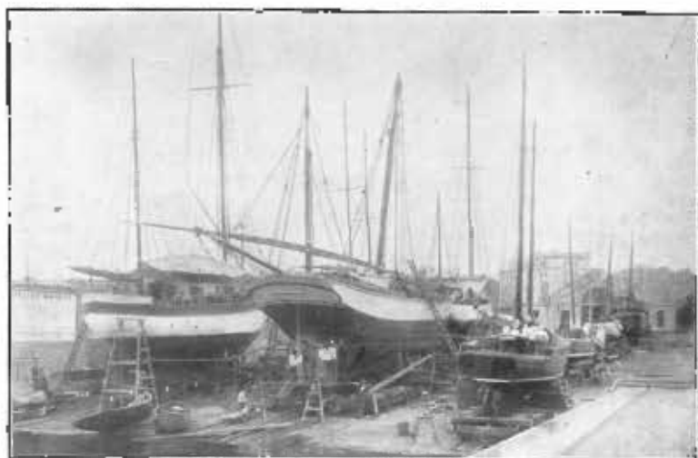
EMBARCACIONES DE DISTINTA CLASE Y FONOLAJE SOBRE LAS TRES VIAS Y CARROS DEL VARADERO PÚBLICO
