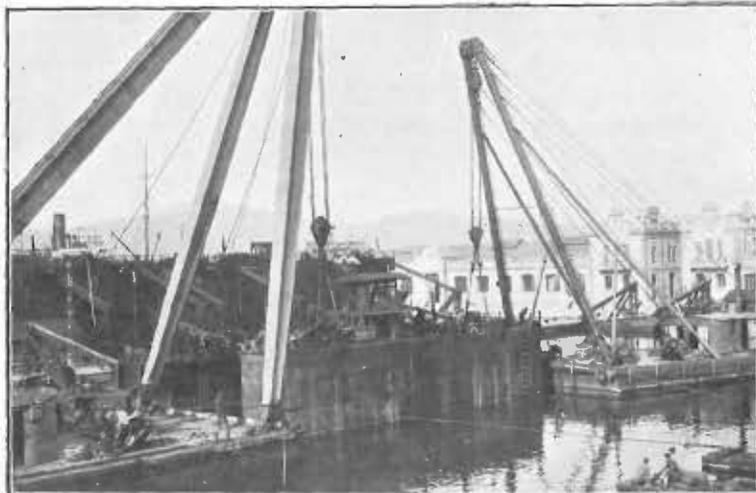
PUERTA SUSPENDIDA DE LAS CÁBRIAS PARA APRECIAR LA FLOTACIÓN
