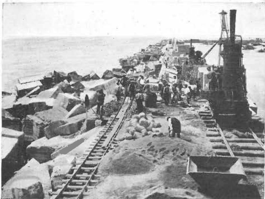
CONSTRUCCIÓN DEL BASAMENTO DEL ESPALDÓN EN LA PARTE CENTRAL DE LA
