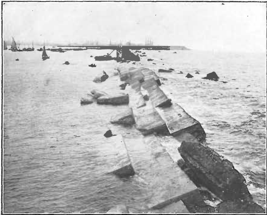
VISTA DE LA BRECHA PRODUCIDA, TOMADA DESDE LA PARTE ALTA DEL ESPALDÓN EN EL LADO SUR
