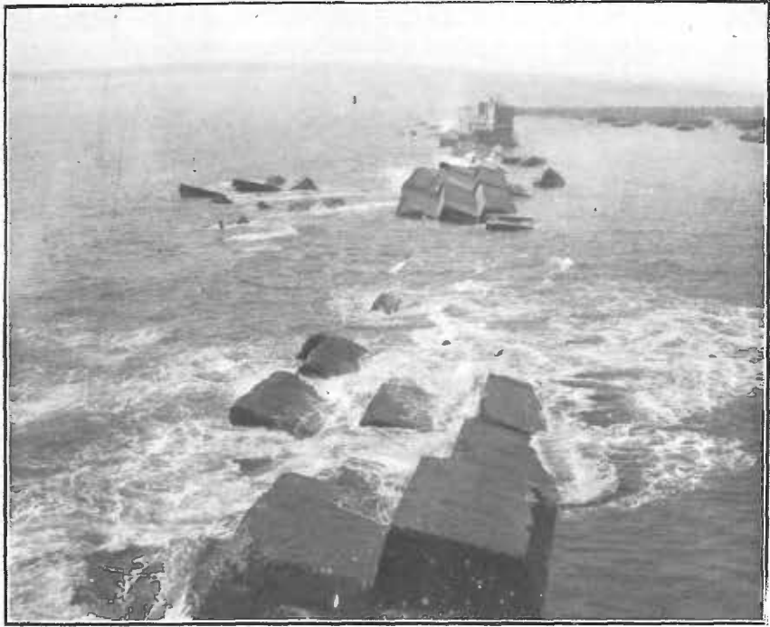
VISTA DE LA BRECHA PRODUCIDA, TOMADA DESDE LA PARTE ALTA DEL ESPALDÓN EN EL LADO NORTE
