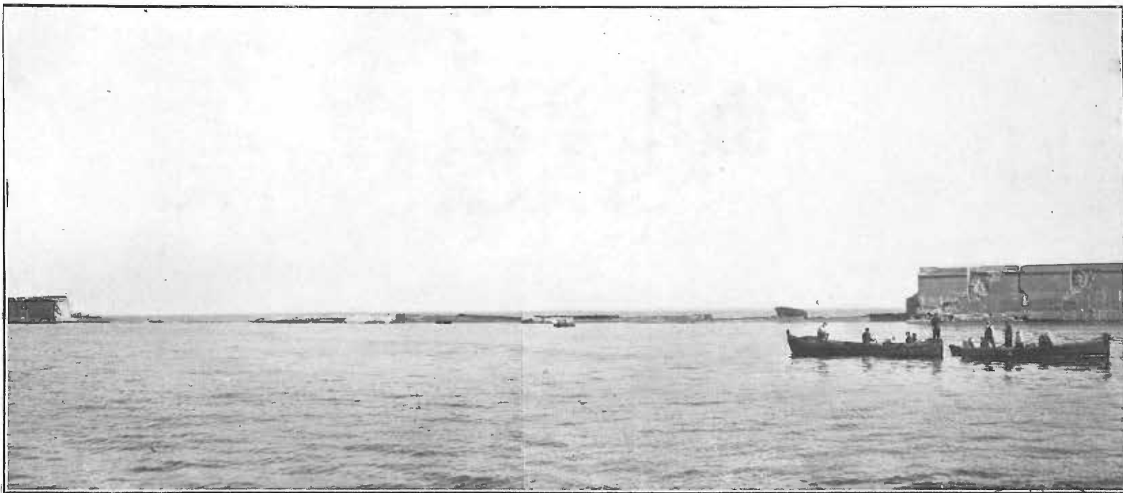
VISTA GENERAL DE LA EXTENSA BRECHA DE 250 METROS DE LONGITUD PRODUCIDA EN EL ESPALDÓN DE LA PROLONGACIÓN DEL DIQUE DEL ESTE, POR EL TEMPORAL, DE FEBRERO DE 1920
