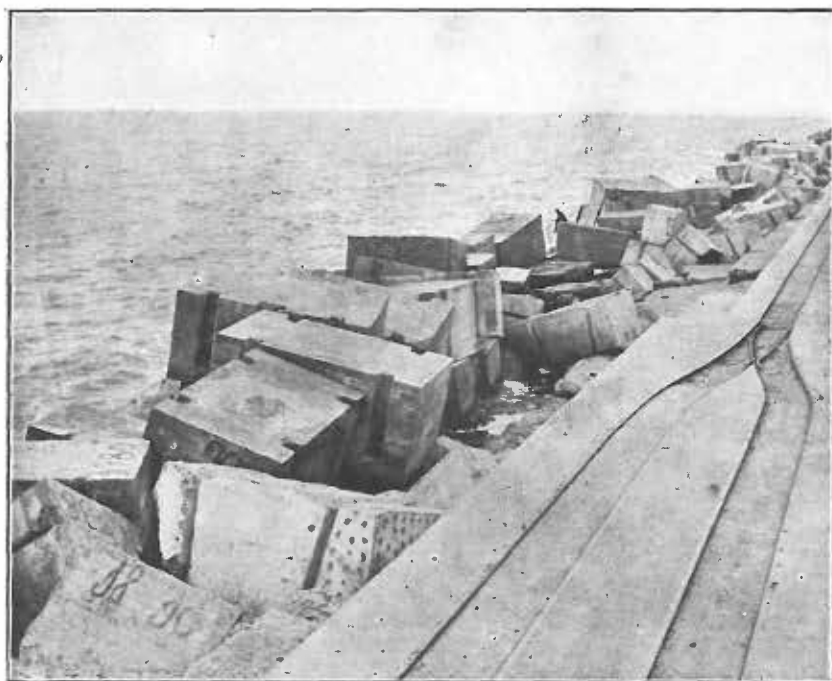
VISTA GENERAL, DE LA BANQUETA Y DEL REFUERZO EXTERIOR DE BLOQUES EN LA ZONA ANTERIOR A LA BRECHA, EN SEPTIEMBRE DE 1921
