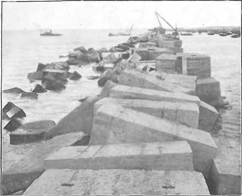
VISTA GENERAL, DE LA BRECHA AL FINAL DEL AÑO 1920, TOMADA DESDE LA PARTE ALTA DEL, ESPALDÓN EN EL LADO NORTE
