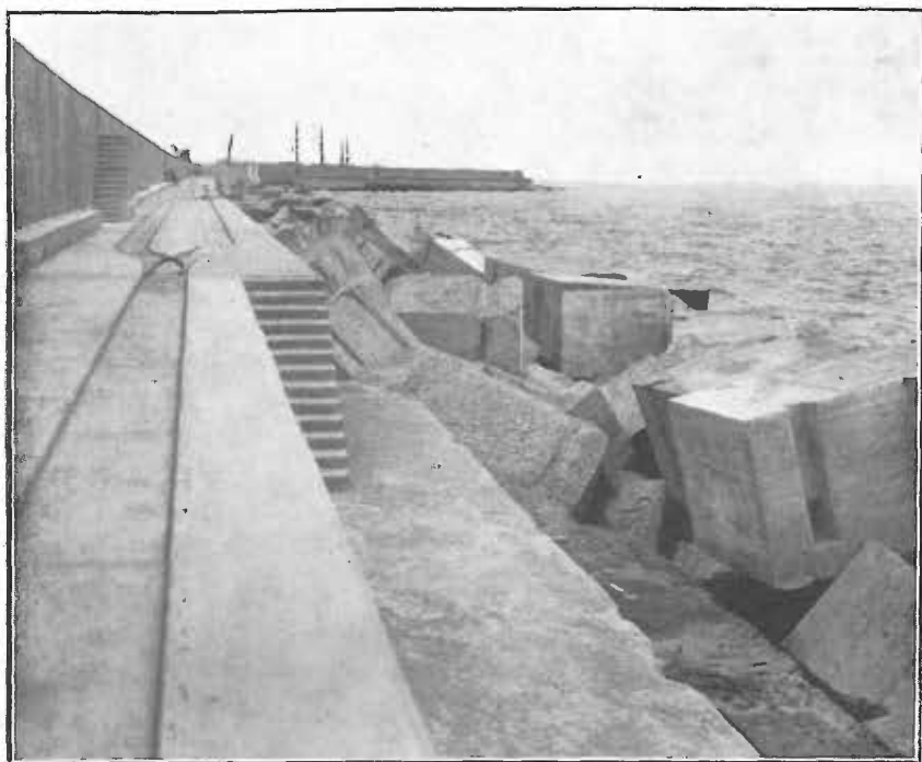
VISTA GENERAL, DE LA BANQUETA DE HORMIGÓN Y RESTINGA EXTERIOR DE BLOQUES EN LA ZONA DEL ORIGEN DEL ROMPEOLAS, EN SEPTIEMBRE DE 1921
