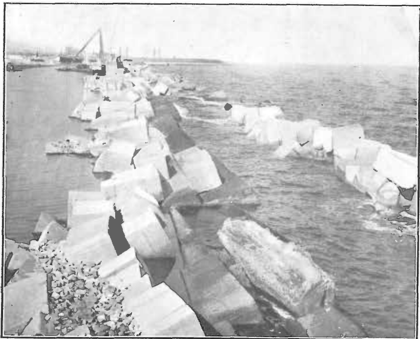
VISTA GENERAL, DE LA BRECHA EN SEPTIEMBRE DE 1920, TOMADA DESDE LA PARTE ALTA DEL, ESPALDÓN EN EL LADO SUR
