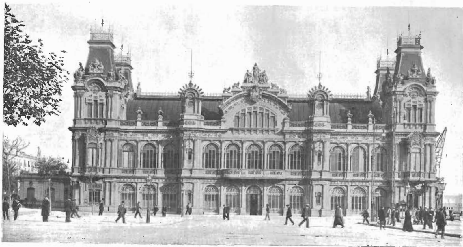
FACHADA PRINCIPAL, DEL EDIFICIO DE LA JUNTA DEL PUERTO
