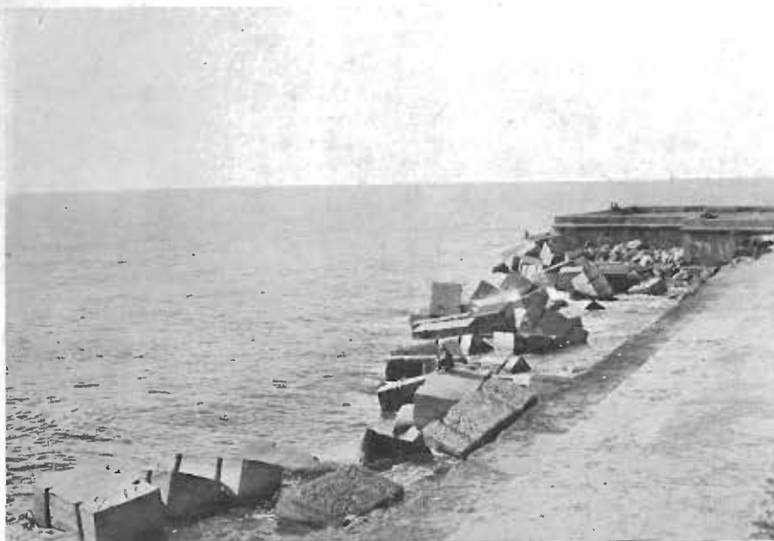
VISTA DE PARTE EXTERIOR DEL ROMPEOLAS EN SU ZONA FINAL, TOMADA DEL ARRANQUE DEL ESPIGÓN
