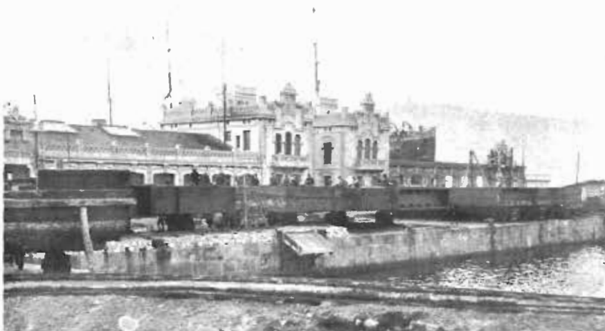
FLOTADORES DE LA 1.ª SECCIÓN DEL DIQUE COLOCADOS SOBRE EL MUELLE DE CATALUNA PARA SU REPARACIÓN
