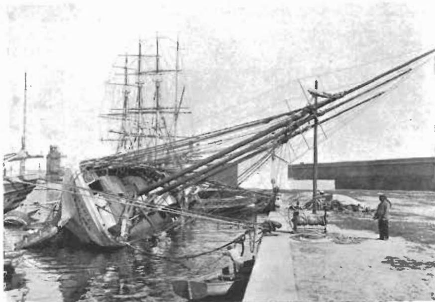
VELERO "SOLGULL," HACIENDO TRABAJOS DE REPARACION Y LIMPIA, TUMBADO EN QUIJLA EN LA INSTALACION DEL MUELLE DE LEVANTE
