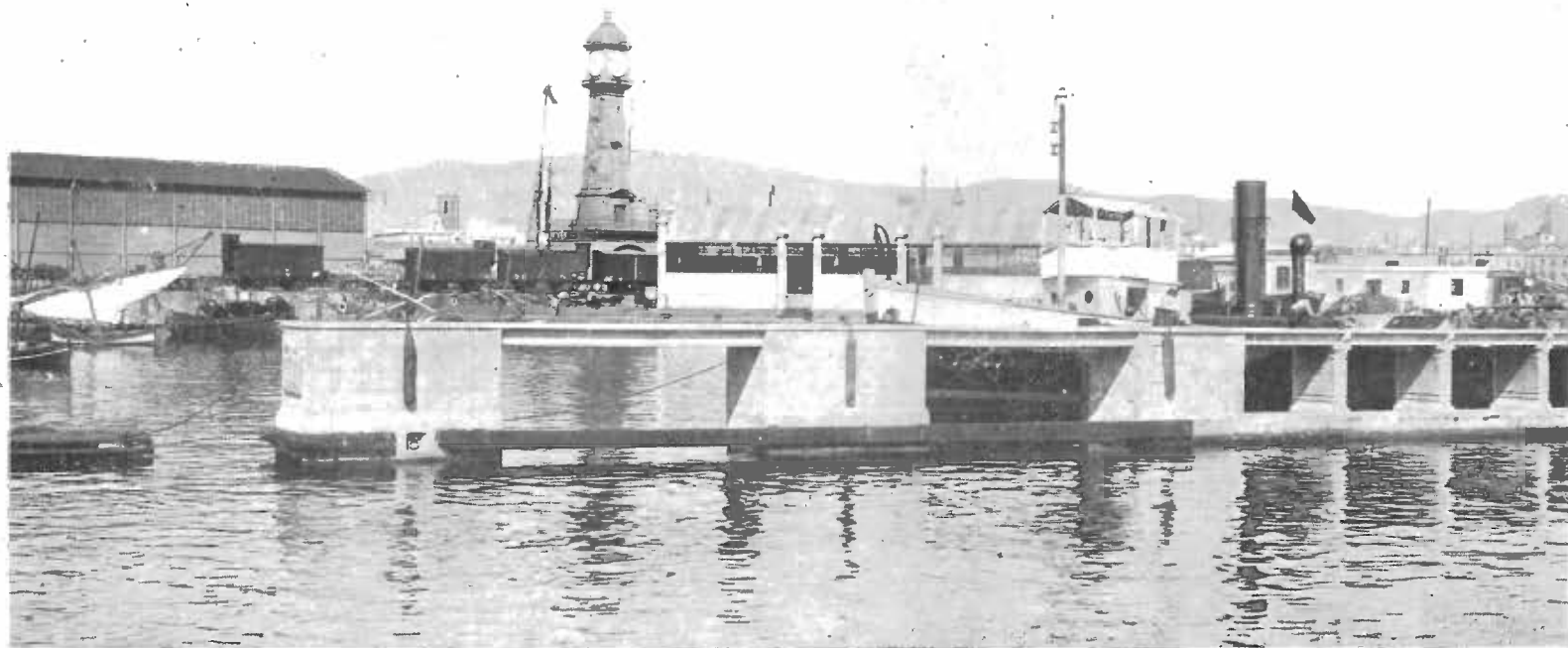
PROLONGACIÓN DEL PUENTE DE SERVICIO DEL VARADERO PÚBLICO PARA EMBARCACIONES DE PEQUEÑO TONELAJE
