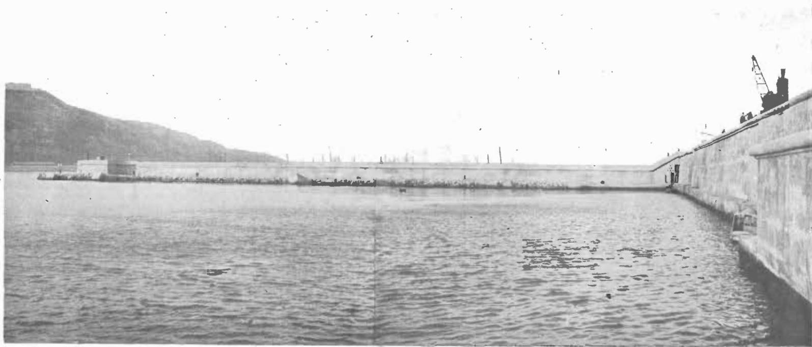
VISTA GENERAL DEL ESPIGÓN Y DE LA PARTE FINAL DE LA PROLONGACIÓN DEL DIQUE
