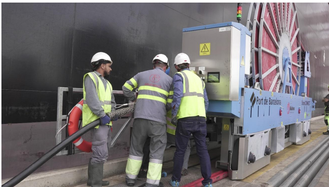
Foto 2. L'OPS de la terminal BEST connectat a un vaixell.
