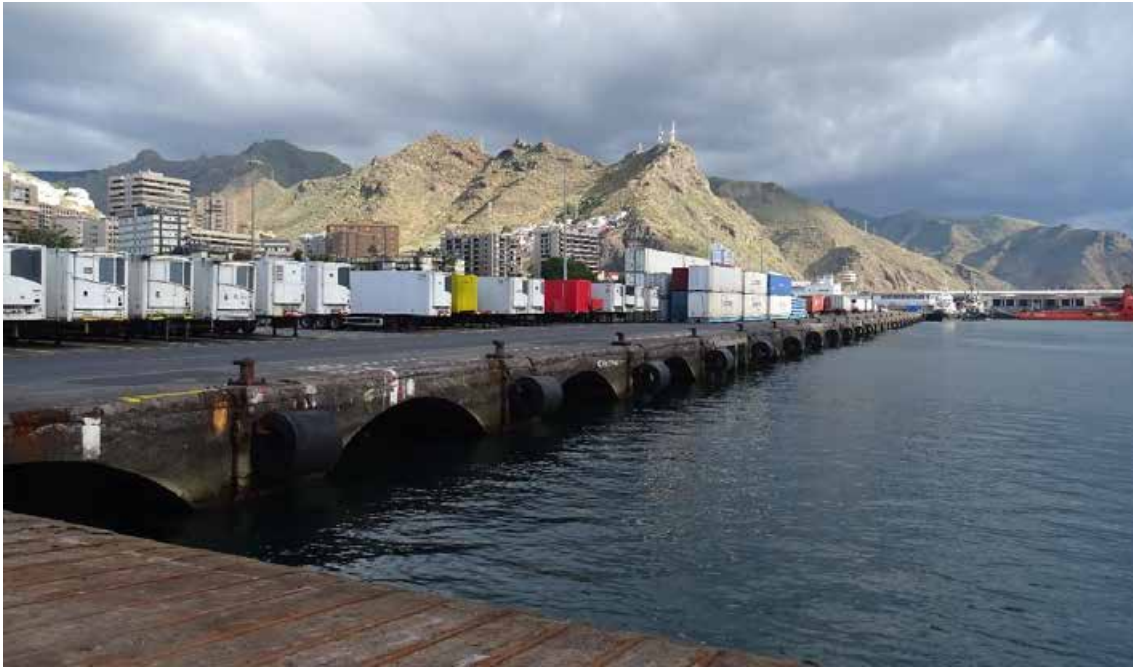
Ilustración 14. Vista de la Terminal de Carga Rodada (TCR). Fuente: Elaboración propia
