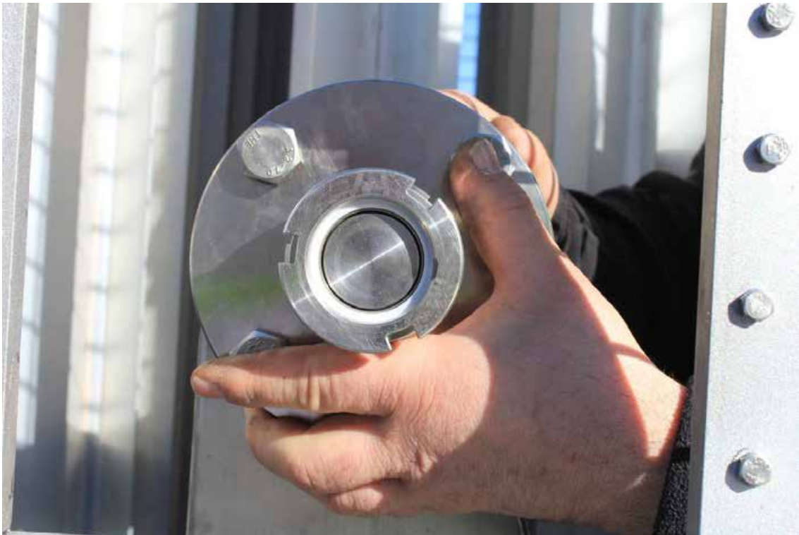
Figura 111. LNG inlet valve to the tanks.
