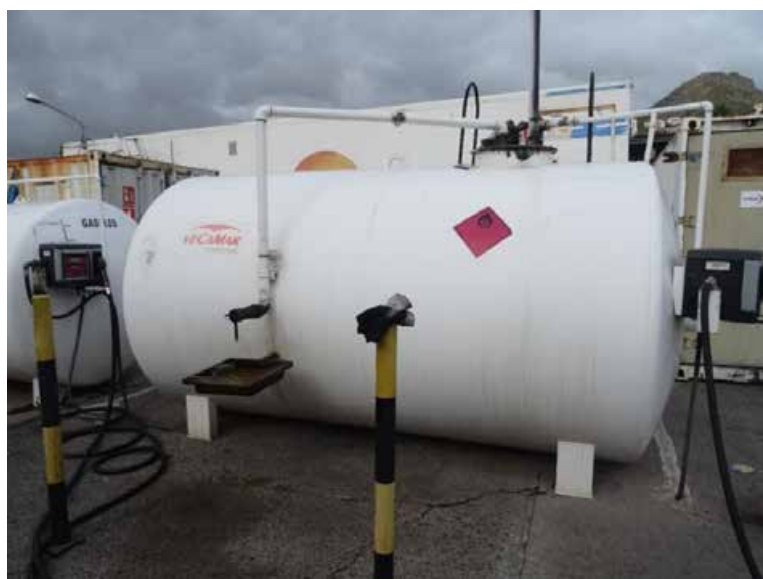
Ilustración 35. Depósito de gasóleo con capacidad de 10.000 litros en terminal TCR. Fuente: Elaboración propia
