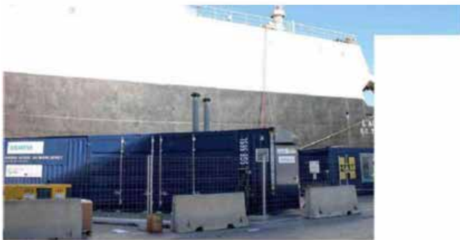
Motor de gas natural suministrando electricidad al buque "C.Audace" de Suardiaz. Foto E. García.
