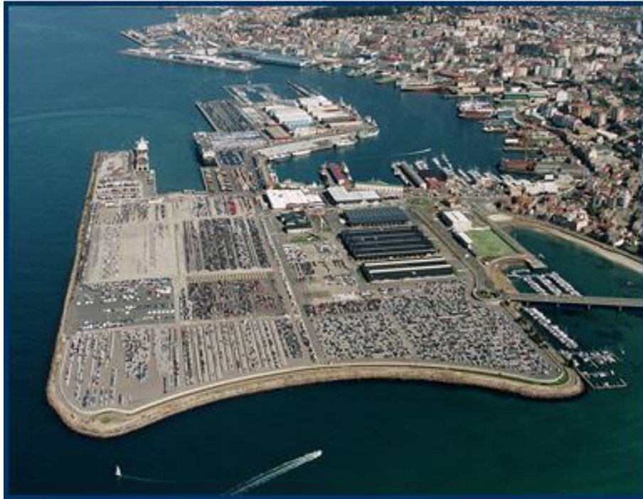
Figura 2.3 Imagen aérea terminal RO-RO. Fuente: proporcionado por la Autoridad Portuaria de Vigo.
