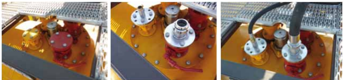
Válvulas Richter con bridas ciegas de transporte. Colocación de bridas con acoplamientos y de mangueras.
