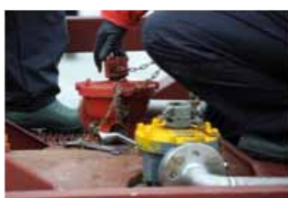
Maniobra de colocación de acopl.
