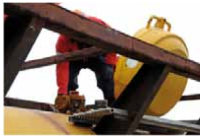
Tapa de protección de valvulería o domo.
