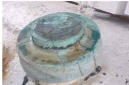
Válvula encofrada con cemento.
