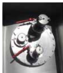
Boca de hombre con válvula para fase líquida y fase gaseosa y válvula de sobrepresión con disco
