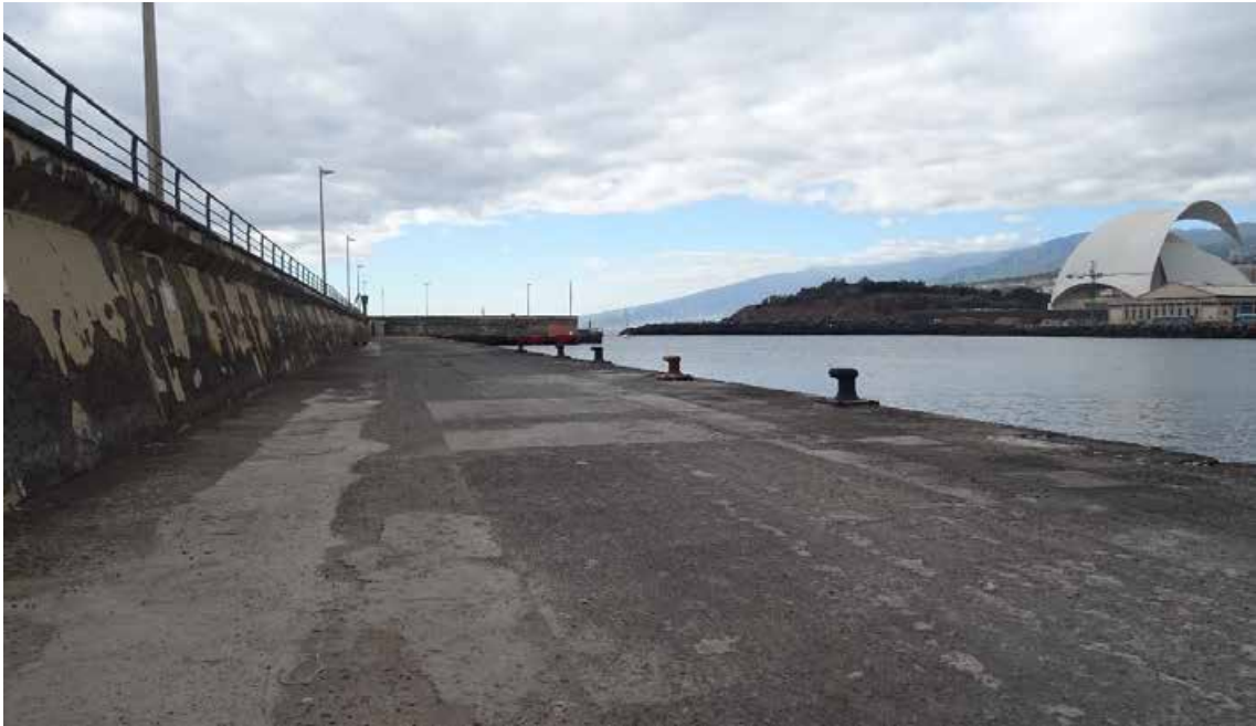
Ilustración 18. Vista del dique de Los Llanos. Fuente: Elaboración propia
