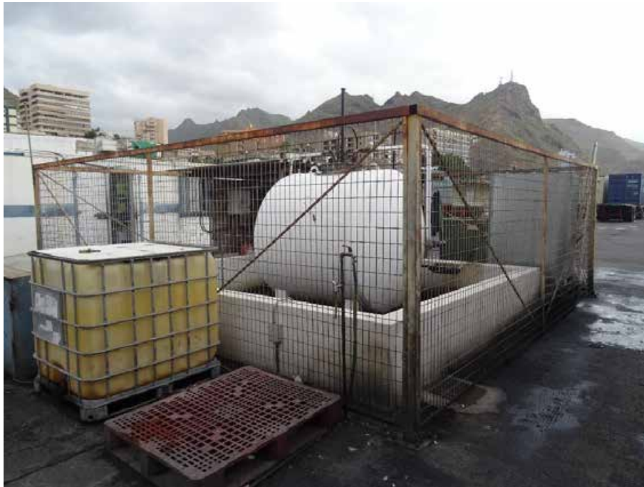
Ilustración 36. Depósito de diésel fuel con capacidad de 5.200 litros. Fuente: Elaboración propia
